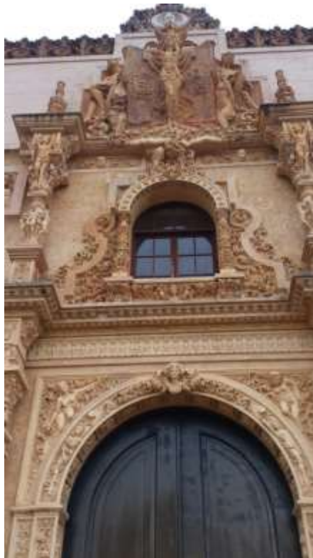
Ilustración 59. Detalles escultóricos de la Fachada de la Escuela Normal Juan Demóstenes Arosemena. Foto Arq. Sebastian Aguilar M.
