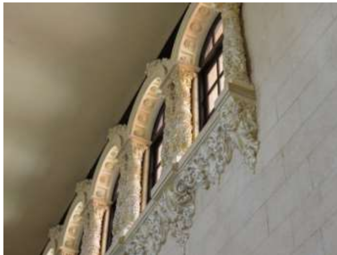
Ilustración 94. Detalle de las ventanas sur hacia el Aula máxima. Foto Arq. Sebastian Aguilar M.
