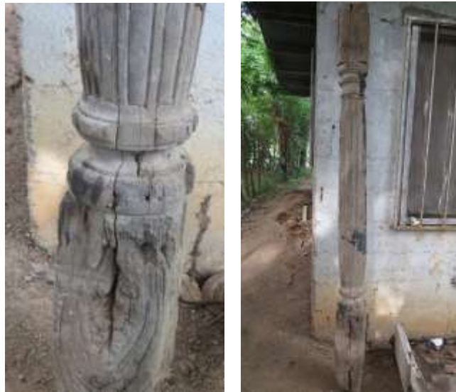
Ilustración 38. Foto de una de las columnas Coloniales que decoraban el Altar Mayor de la Catedral Santiago Apóstol. Foto de Arquitecto Sebastian Aguilar M.
