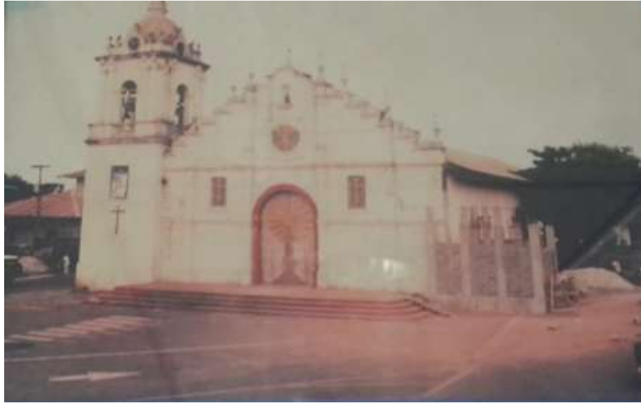
Ilustración 170. Foto donde se aprecia el inicio de la construcción de la Segunda torre de la Catedral Santiago Apóstol.
