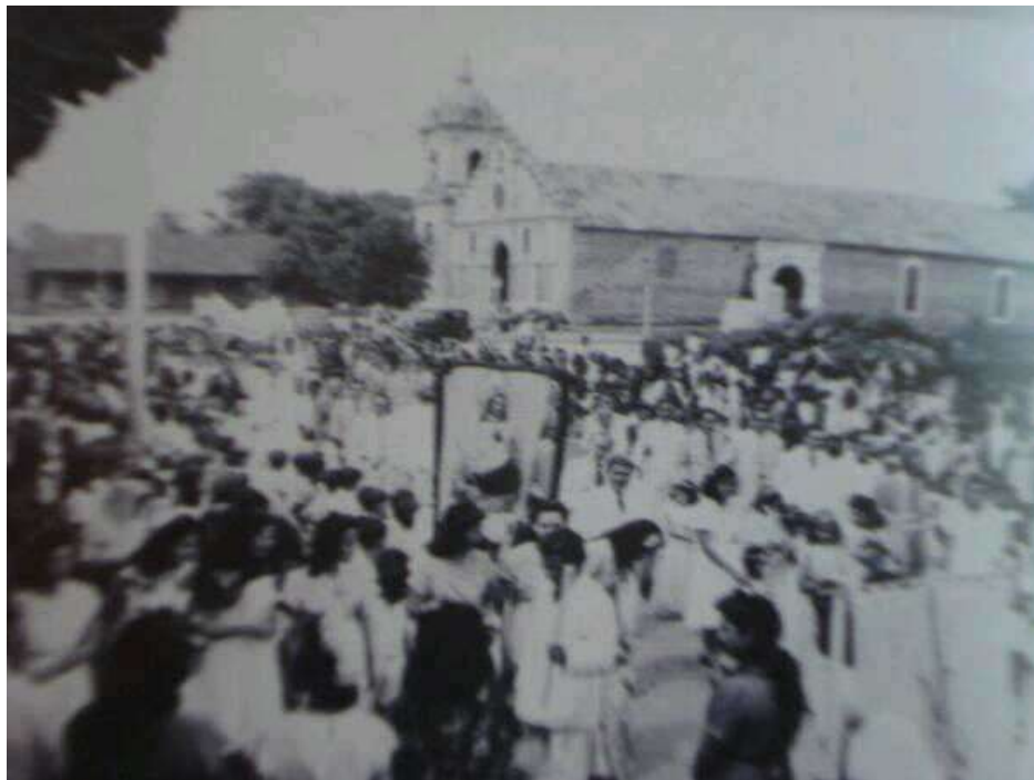
Ilustración 167. Reparaciones de la Catedral de Santiago Apóstol en 1950. Obsérvese antes de esta remodelación se notaban los ladrillos de la Iglesia vistos. Luego fueron repellados. Una sola torre. Foto del Libro Por los Predios de Urracá de Pedro J. Medida.
