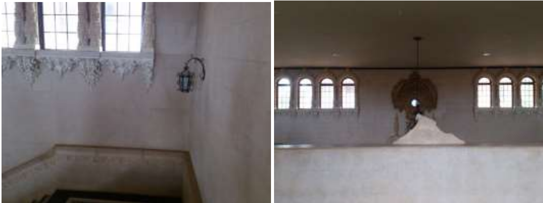
Ilustración 93. Detalle de las ventanas sur hacia el Aula máxima. Foto Arq. Sebastian Aguilar M.
