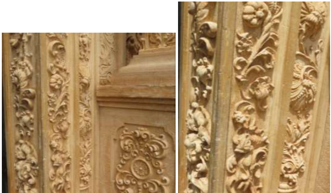
Ilustración 55. Detalles de elementos de naturaleza en relieve denominados como arabescos. Foto del Arq. Sebastián Aguilar M.
