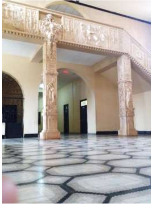
Ilustración 69. pilastras del Vestíbulo de la Escuela Normal Juan Demóstenes Arosemena. Foto Arq. Sebastian Aguilar M.
