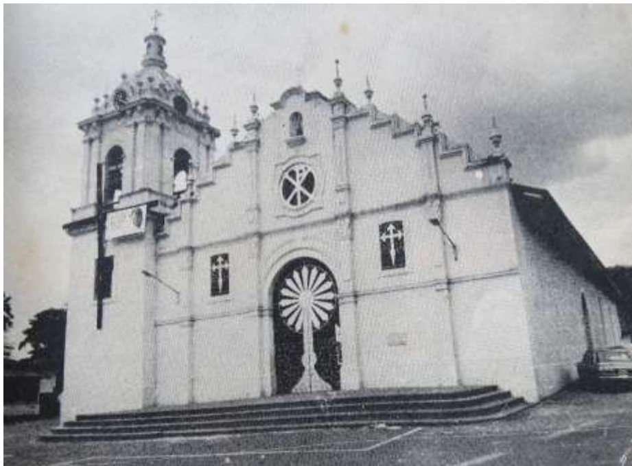
Ilustración 169. Imagen de La Catedral Santiago Apóstol de Santiago de Veraguas. Después de la remodelación. Se aprecian las puertas donadas por el Sr. Brin, se cambian las ventanas antiguas y se le colocan detalles decorativos a la fachada. Foto del Libro Por los Predios de Urracá de Pedro J. Medida.
