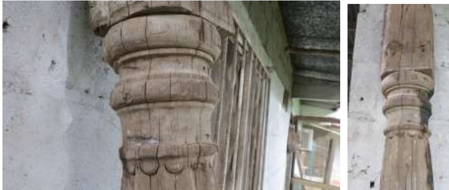
Ilustración 39. Foto de una de las columnas Coloniales que decoraban el Altar Mayor de la Catedral Santiago Apóstol. Foto de Arquitecto Sebastian Aguilar M.
