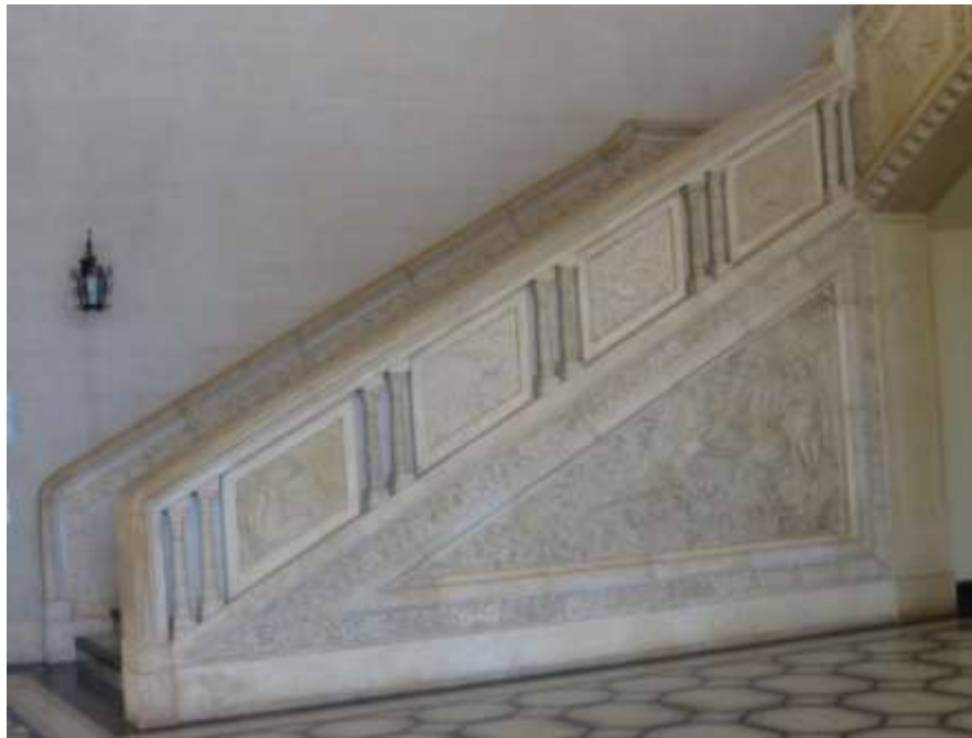
Ilustración 90. detalles en las Escaleras del vestíbulo. Foto Arq. Sebastian Aguilar M.
