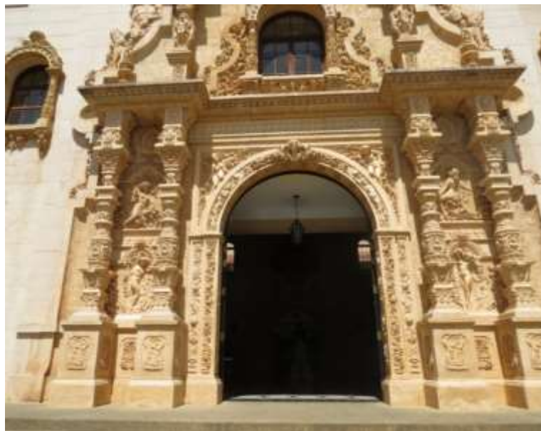
Ilustración 43. Arriba Fachada de la Escuela Juan Demóstenes Arosemena. Foto del Arq. Sebastián Aguilar M.
