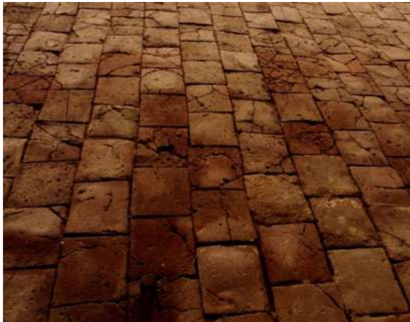
Ilustración 15. Pisos de ladrillo utilizados a partir del Siglo XVIII, en la ciudad de Santiago de Veragua. Foto Arq. Sebastian Aguilar.
