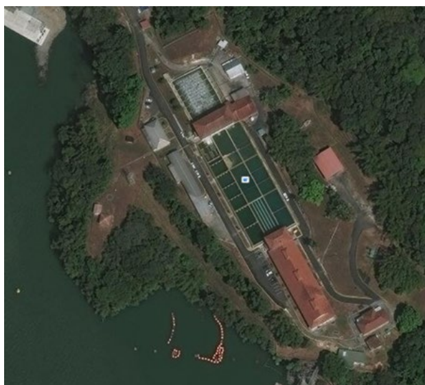
Figura 1. Sito de muestreo 1. Estación de bombeo de agua cruda de Gamboa, de la planta potabilizadora de Miraflores. Coordenadas 9^{\circ} 00' 10'' \text{N} - 79^{\circ} 35' 37'' \text{W} .
