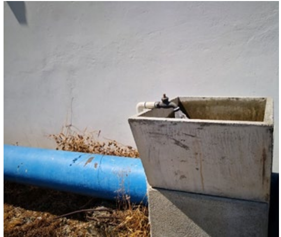
Figura 14. Punto de colecta de agua tratada después del proceso de potabilización dentro de la planta potabilizadora de Chilibre.
