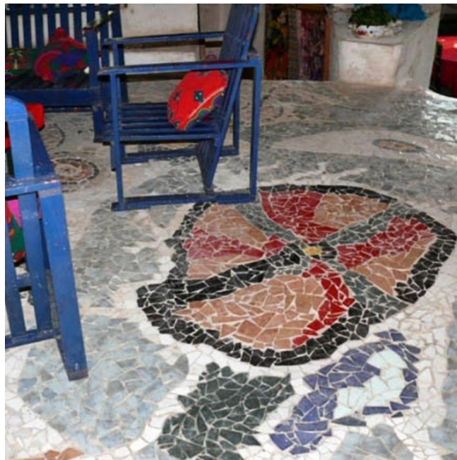
Figura 11 Trencadis en uno de los pisos del Viejo Módulo
