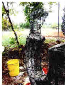
Figura 7: Recubierta con malla para repello, vista 2
