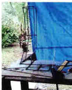
Figura 2: Estructura en hierro, vista 1
