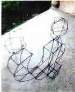
Figura 4: Instalación de malla de repello, vista 3
