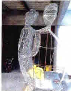
Figura 5: Estructura con malla de repello, vista 4
