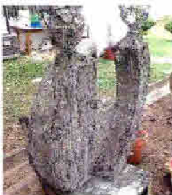
Figura 8: Técnica de adición del mortero, moldeamos con espátula y palaustre, vista 1
