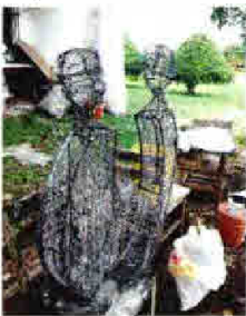
Figura 6: Recubierta con malla para repello, vista 1
