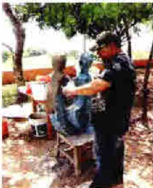
Figura 12: Repetición de aplicación de aditivo y cubierta con pasta de mortero, vista 2
