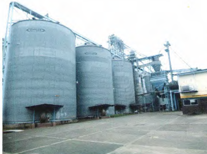
Figura 24. Silos metálicos comerciales
