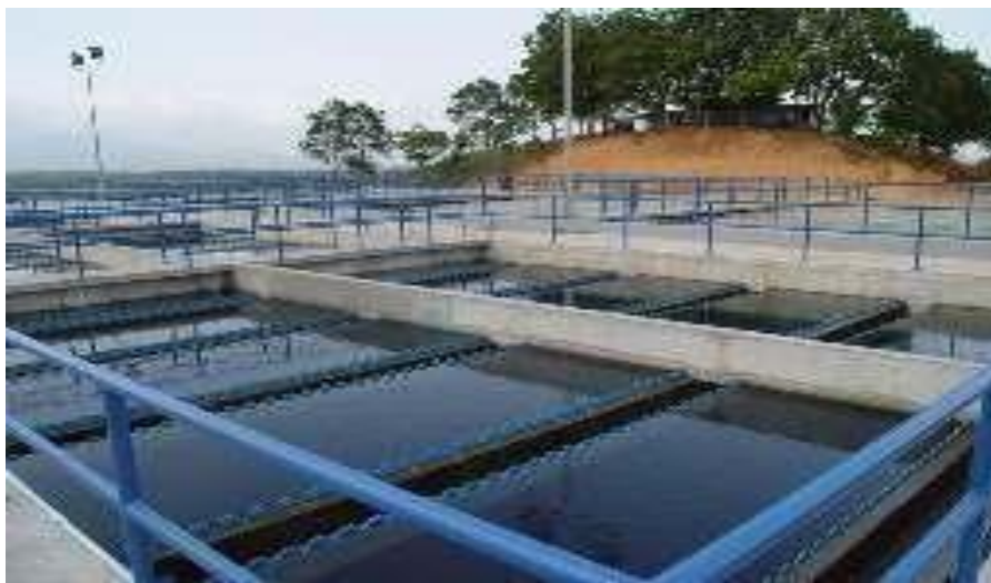
Figura 17 Planta potabilizadora de Chepo.
