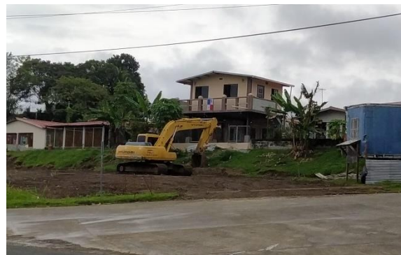
Figura 54 movimiento de tierra para incluir un uso comercial sin evaluación para su inclusión en la zona urbana del área
