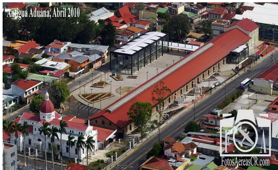
Edificio de la Aduana de Costa Rica
