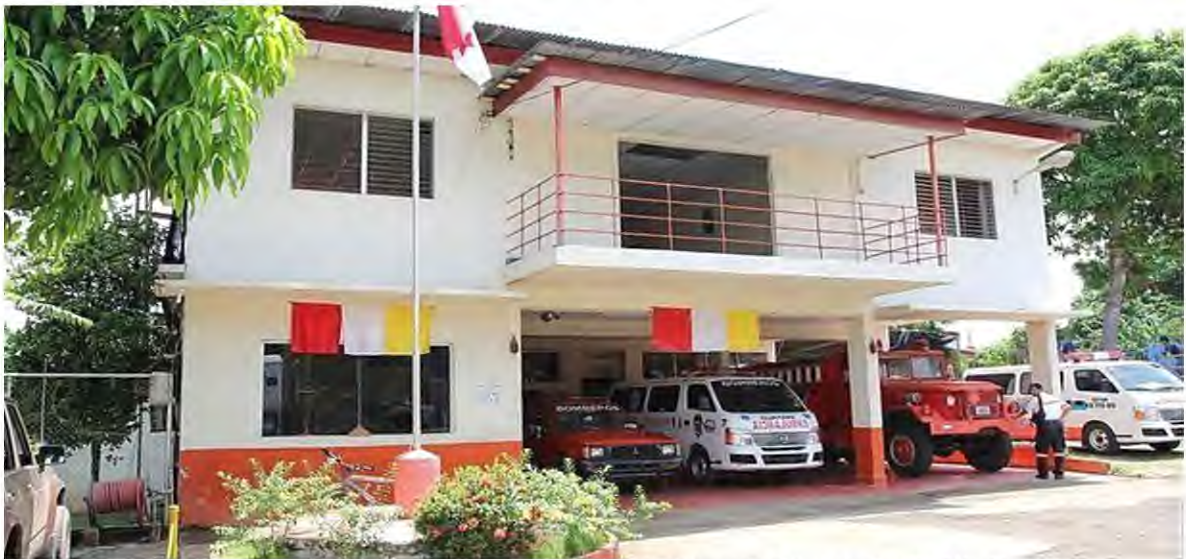
Figura 11. Estación de Bomberos Guararé.
