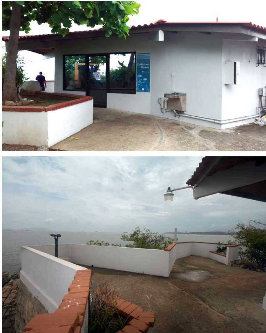
Figura 26. Vista del área actual de exhibiciones marinas y mirador del mismo.
