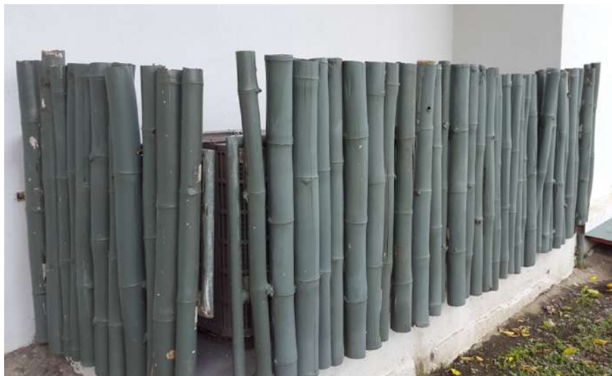
Figura 15. Parapeto para ocultar las unidades de aire acondicionado de las oficinas del Centro.
