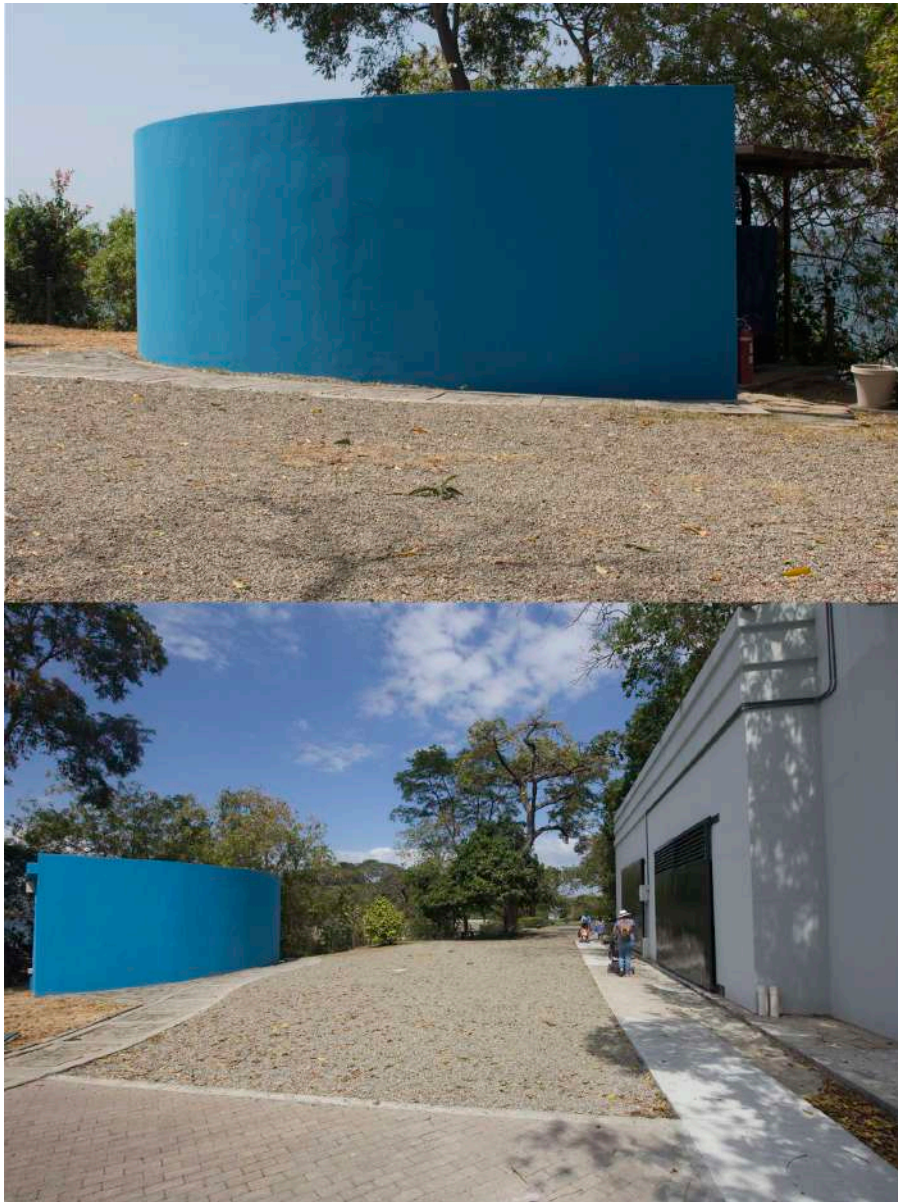
Figura 22. Mampara frente al segundo Bunker, funciona como obstáculo visual hacia el área donde se ubican los equipos de bombeo para las exhibiciones.
