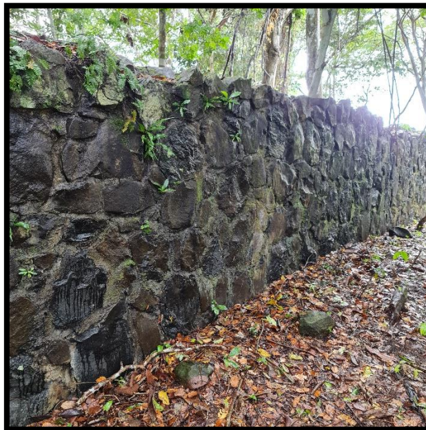
Fotografía 4. 9: Parte Externa de estructura dos
