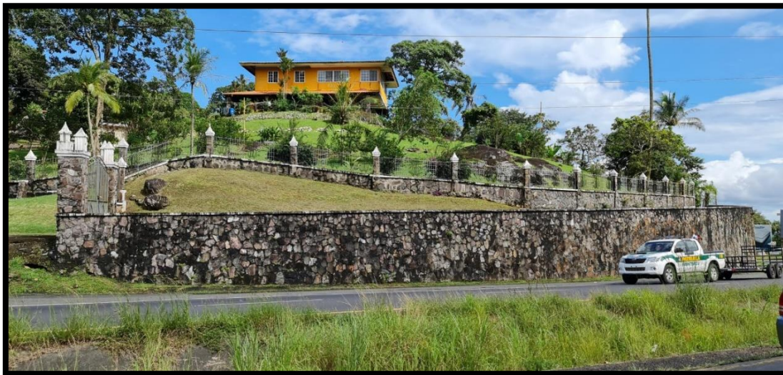
Fotografía 4. 14: Muro en localidad de campana
