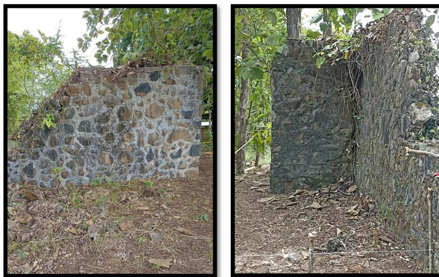
Fotografía 4. 12: Muros de Estructura uno
