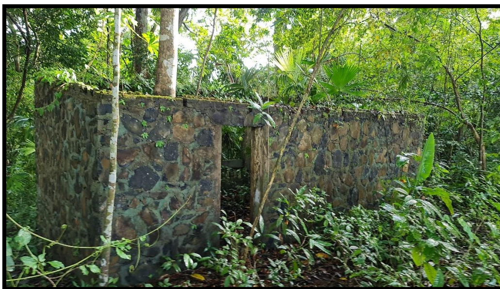
Fotografía 4. 10: Estructura fuera del área del proyecto
