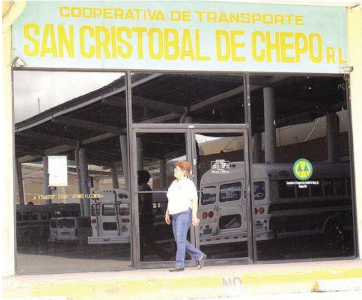
Figura 12 Instalaciones de la Cooperativa de Transporte San Cristóbal de Chepo.
