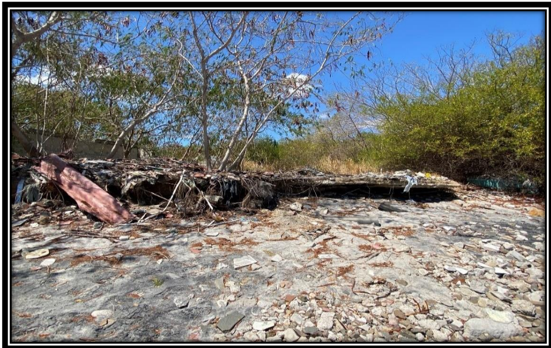
Figura 10. Antiguas instalaciones turísticas, destruidas por el avance del nivel del mar
