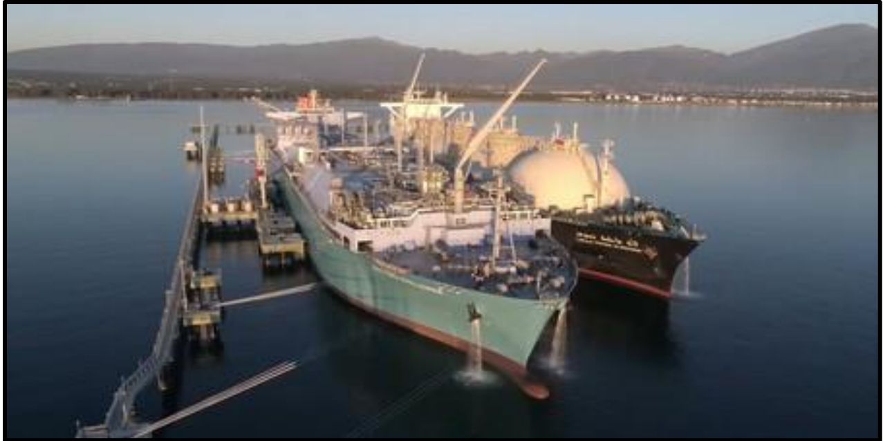
Figura. 4 Primer Puerto en Alemania, diseñado para recibir el GNL
