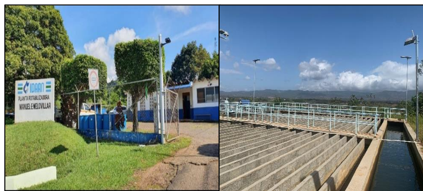
Figura N°25 Planta Potabilizadora de Cabra.
