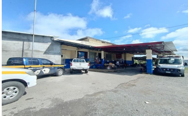
Figura N° 18 Centro de Salud del Corregimiento de Pacora
