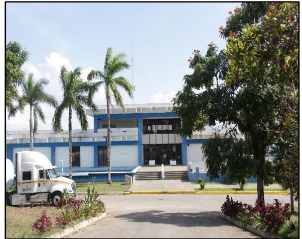
Figura N°24 Planta Potabilizadora Chilibre.
