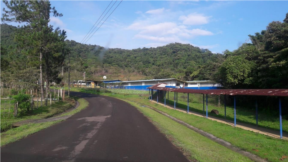
Ilustración 3 Instalaciones del IPTA Alto de Piedra.
