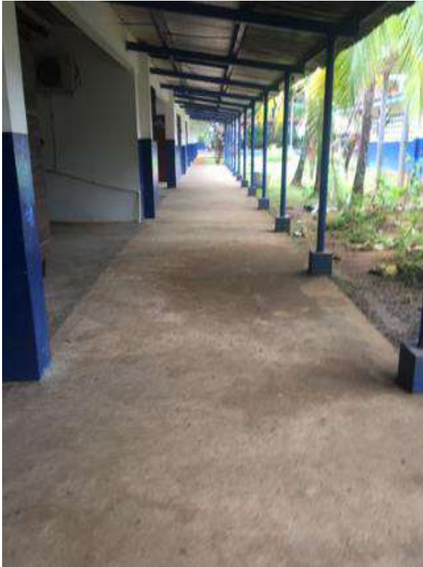
Imagen 45: Pasillo externo de un pabellón sin acabado
