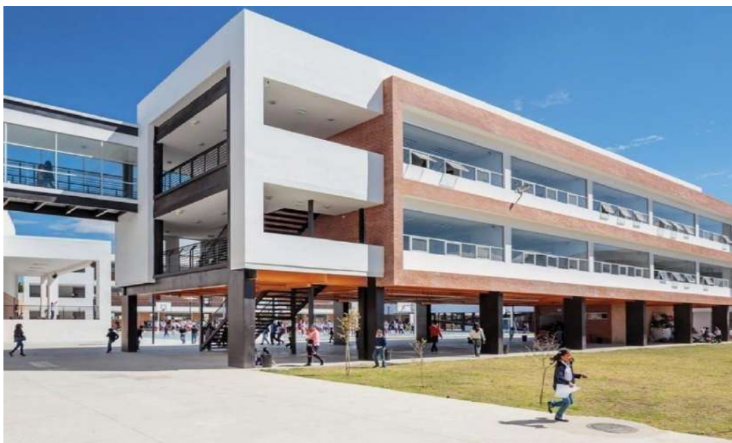
Imagen 98: Fachada con elementos horizontales y verticales
