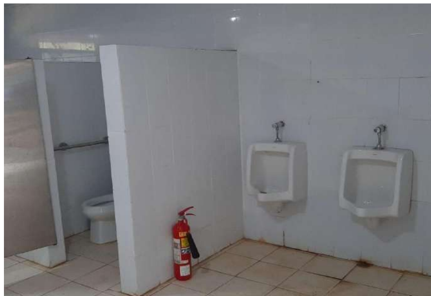
Imagen 79: Baños de Caballeros
