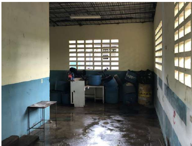
Imagen 87: Depósito general de talleres
