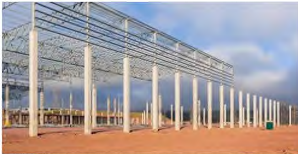
Imagen 71. Estructura mixta de concreto y acero. Fuente: Spectra Ingeniería
