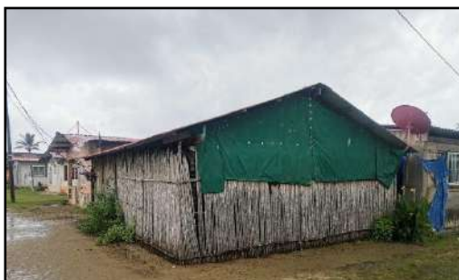
Ilustración 3 Edificaciones existentes en las islas: Fotografía del autor
