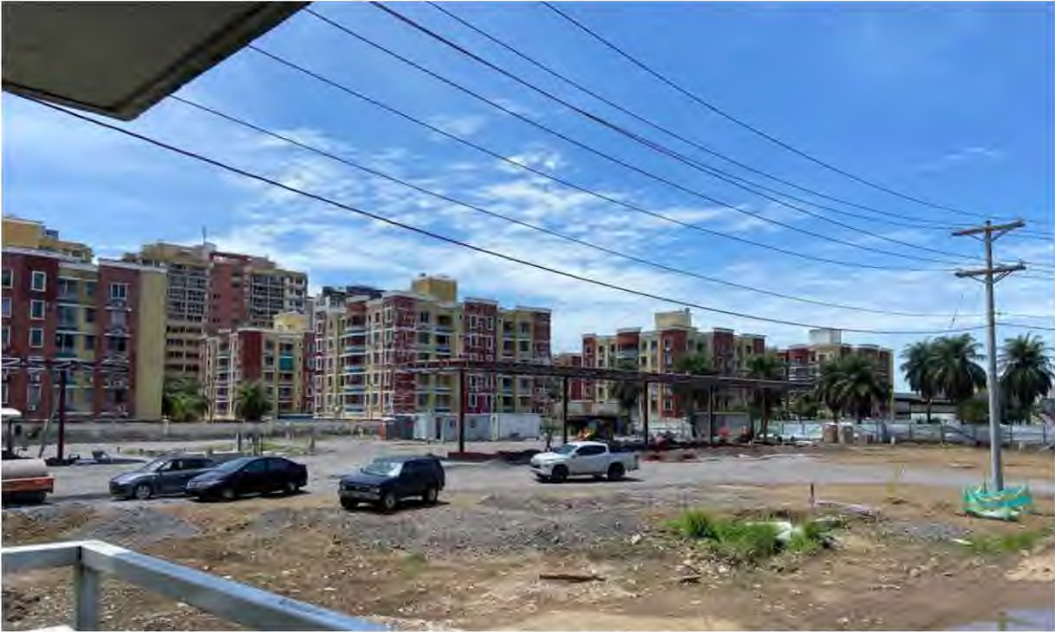
Figura 52. Vista del residencial Torres de Milán y construcción de gasolinera, contiguo al terreno. Fuente: Fotografía Propia.
