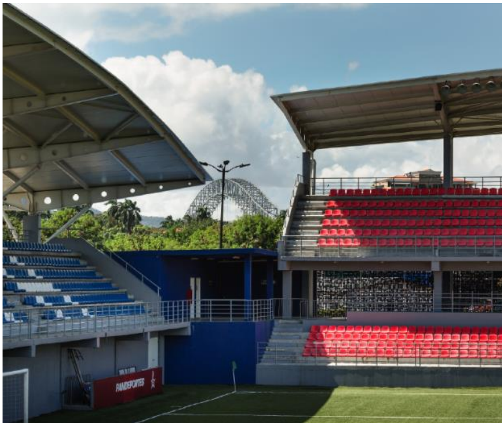
Ilustración 22 Vista interna de Área de Graderías del Estadio Maracanã.
