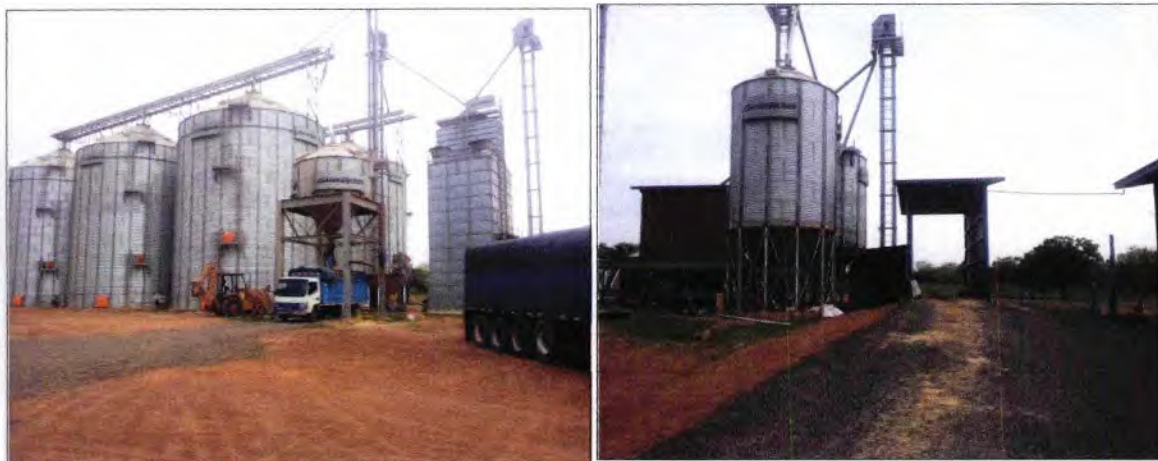
ALMACENAMIENTO DE GRANOS EN COOPROSA, R.L. (SILOS)
