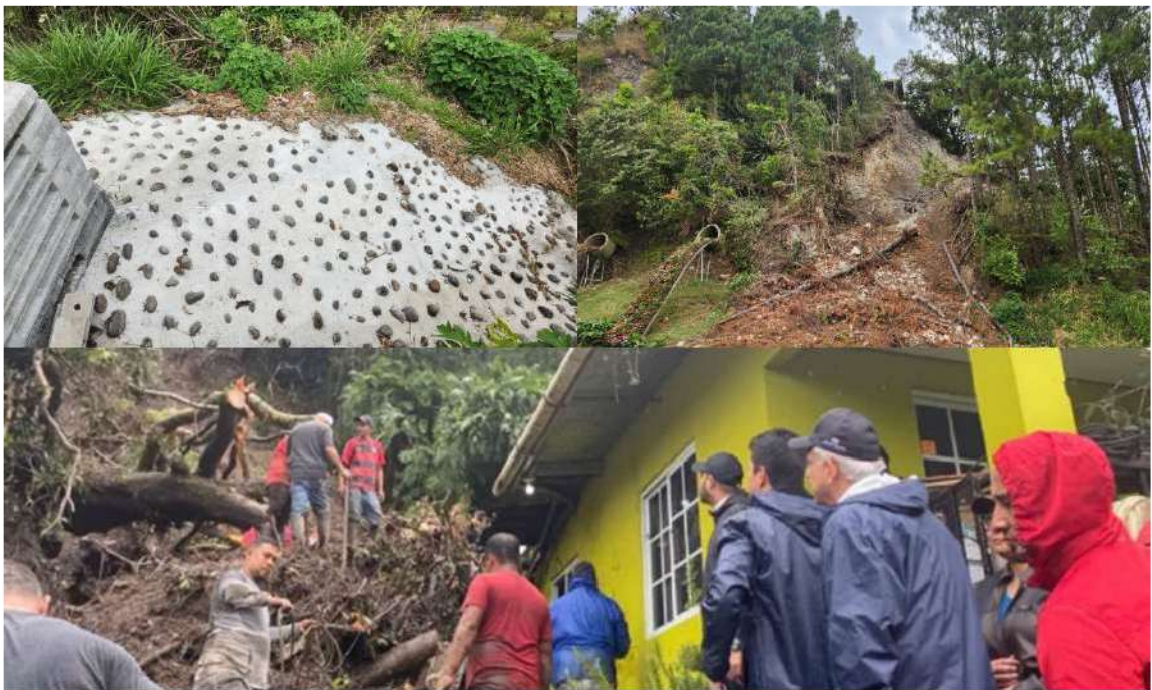
Figura 10: Afectaciones por deslizamientos en Boquete
