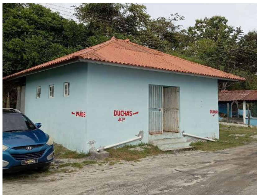
Anexo 4. Baños del restaurante de la Junta Comunal de La Ermita. Foto tomada por el autor.
