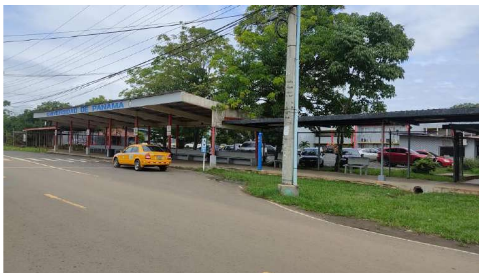
Ilustración 18. Vista de marquesina y parada del de C.R.U.P.O, fuente propia, año 2024
