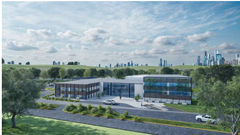
Ilustración 39 Perspectiva general exterior. Fuente: autor
