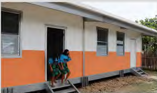
Figura 102. MEDUCA instalará aulas modulares y multiuso en Comarca. Fuente: Ruíz, N. 2023. Telemetro. https://www.telemetro.com/nacionales/meduca-instalara-aulas-modulares-y-multiuso-comarca-n5895766
