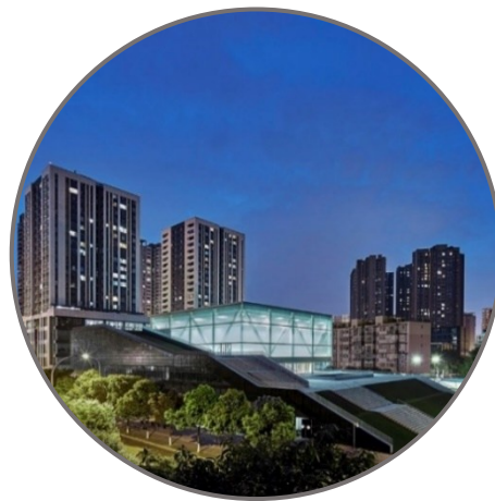
Ilustración 9. Centro Deportivo Comunitario San Wayao
