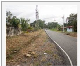
Falta de aceras hacia el campo deportivo.
