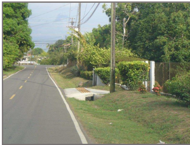
Ilustración 19. Sistema pluvial abierto típico y entrada a residencia.
