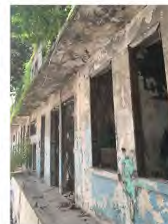
Fotografías - Estado Actual del Inmueble
