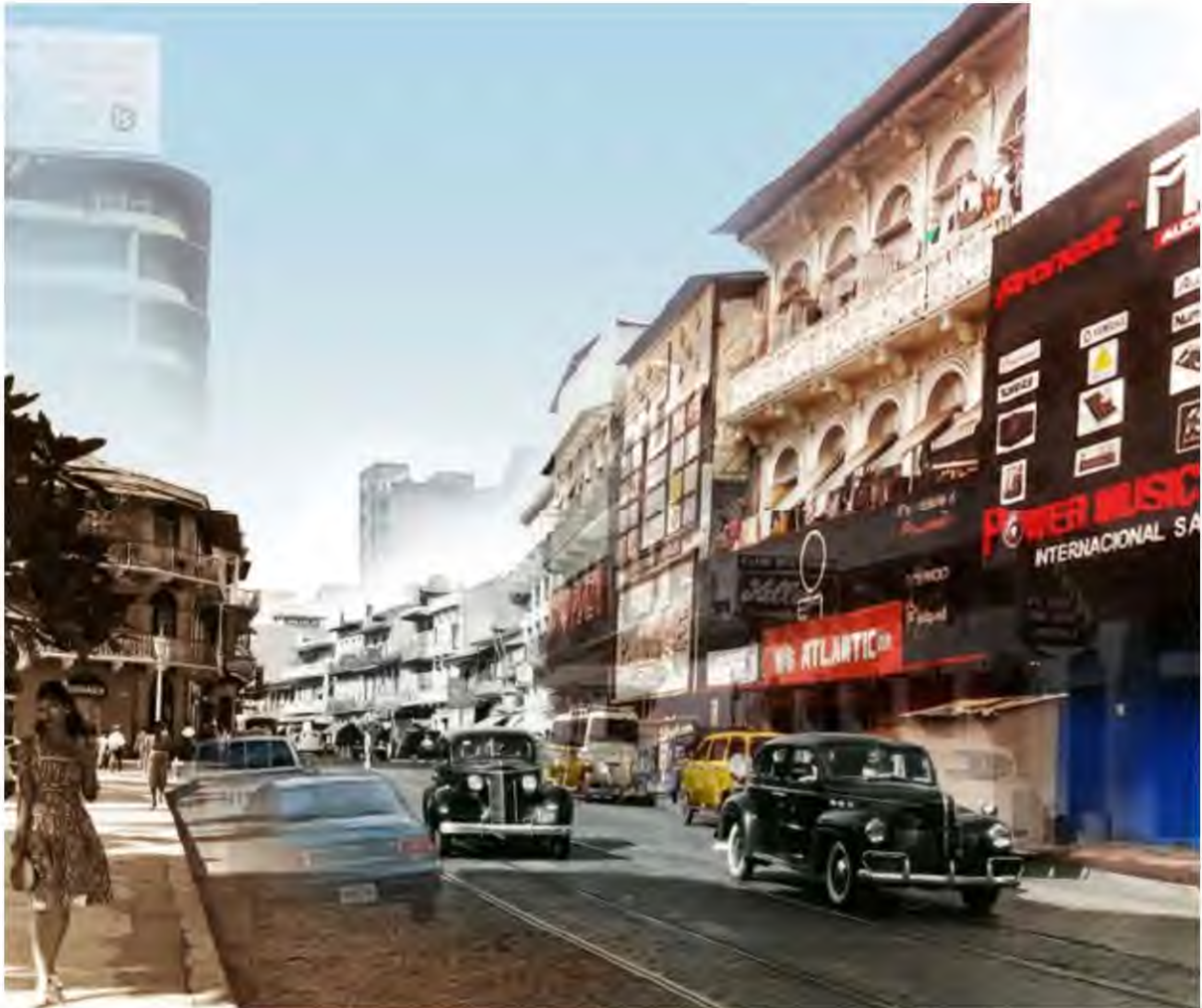
Figura 12. Transformación de la Avenida Central
