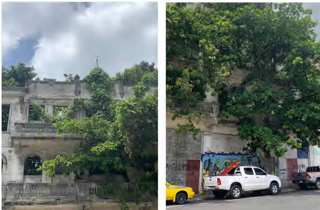
Figura 49. Compendio de fotografías: Estado actual de la fachada norte - Calle L
