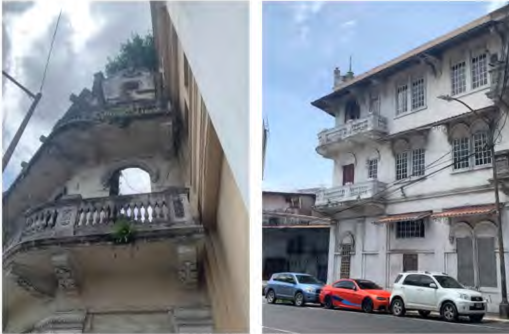
Figura 51. Compendio de fotografías: Estado actual de la fachada norte – Calle L
