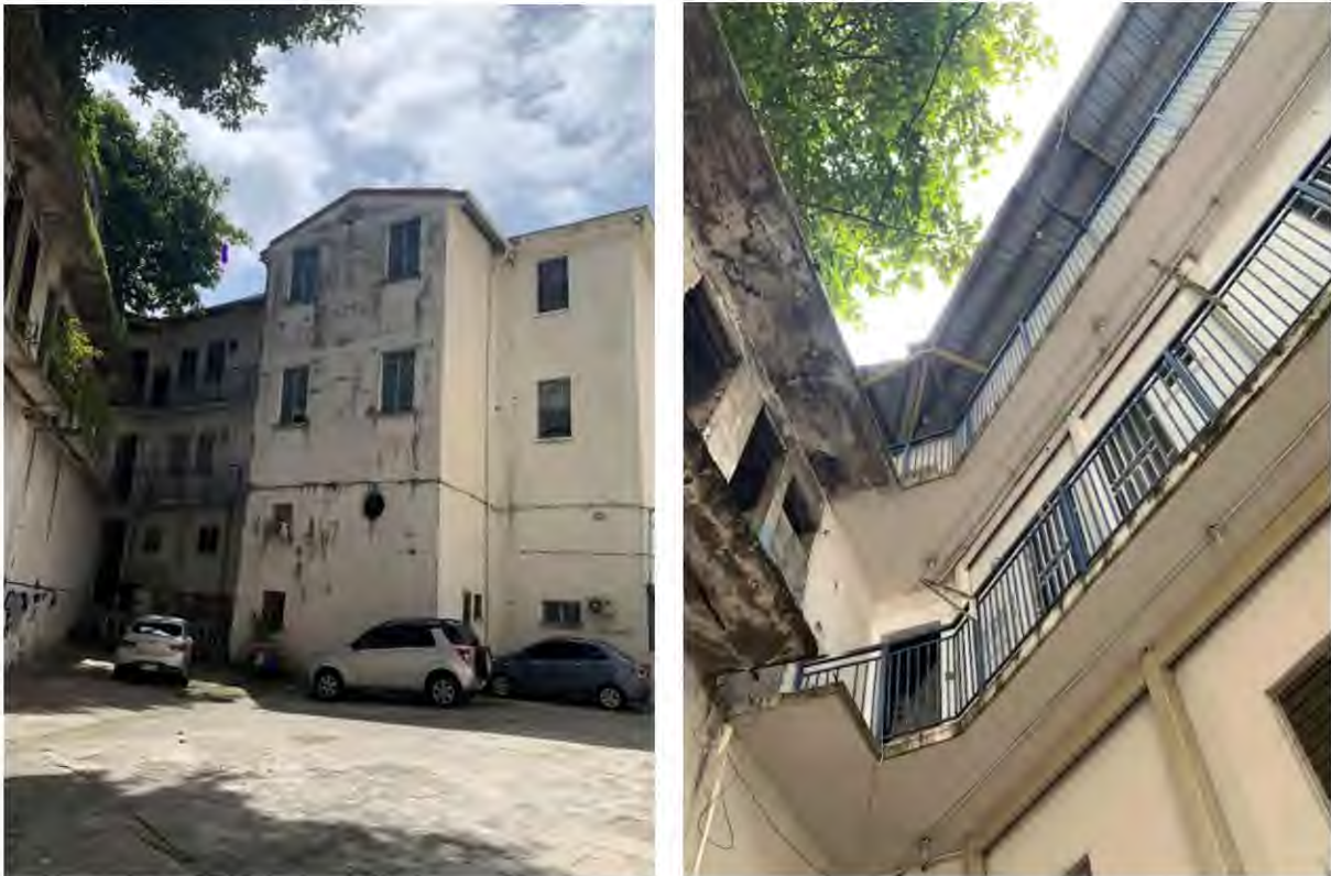
Figura 56. Compendio de fotografías: Estado actual de la fachada interior A
