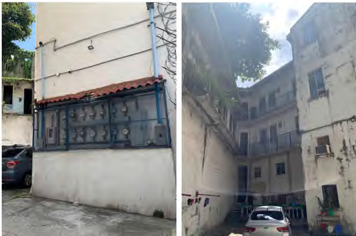
Figura 57. Compendio de fotografías: Estado actual de la fachada interior A
