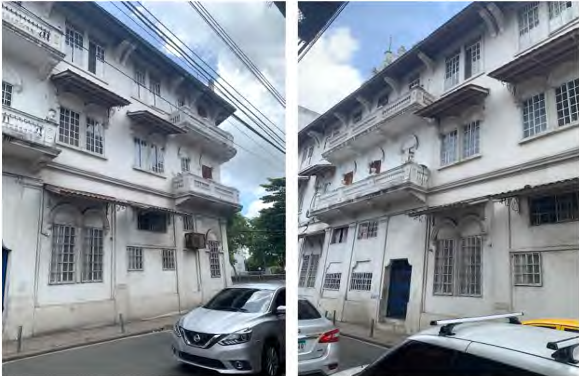
Figura 53. Compendio de fotografías: Estado actual de la fachada posterior - Calle Estudiante
