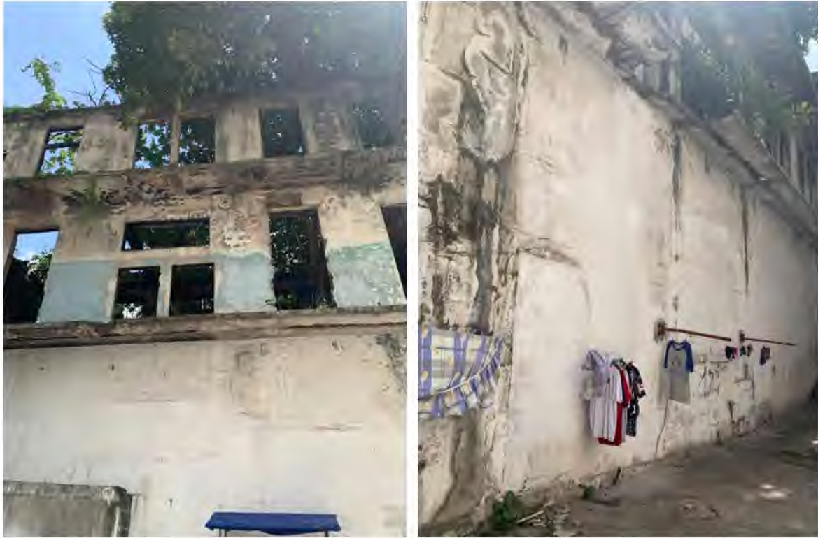
Figura 59. Compendio de fotografías: Estado actual fachada interior B
