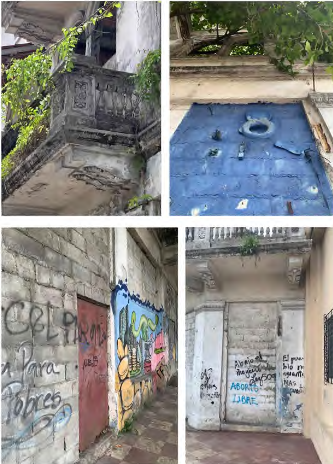
Figura 50. Compendio de fotografías: Estado actual de la fachada norte – Calle L
