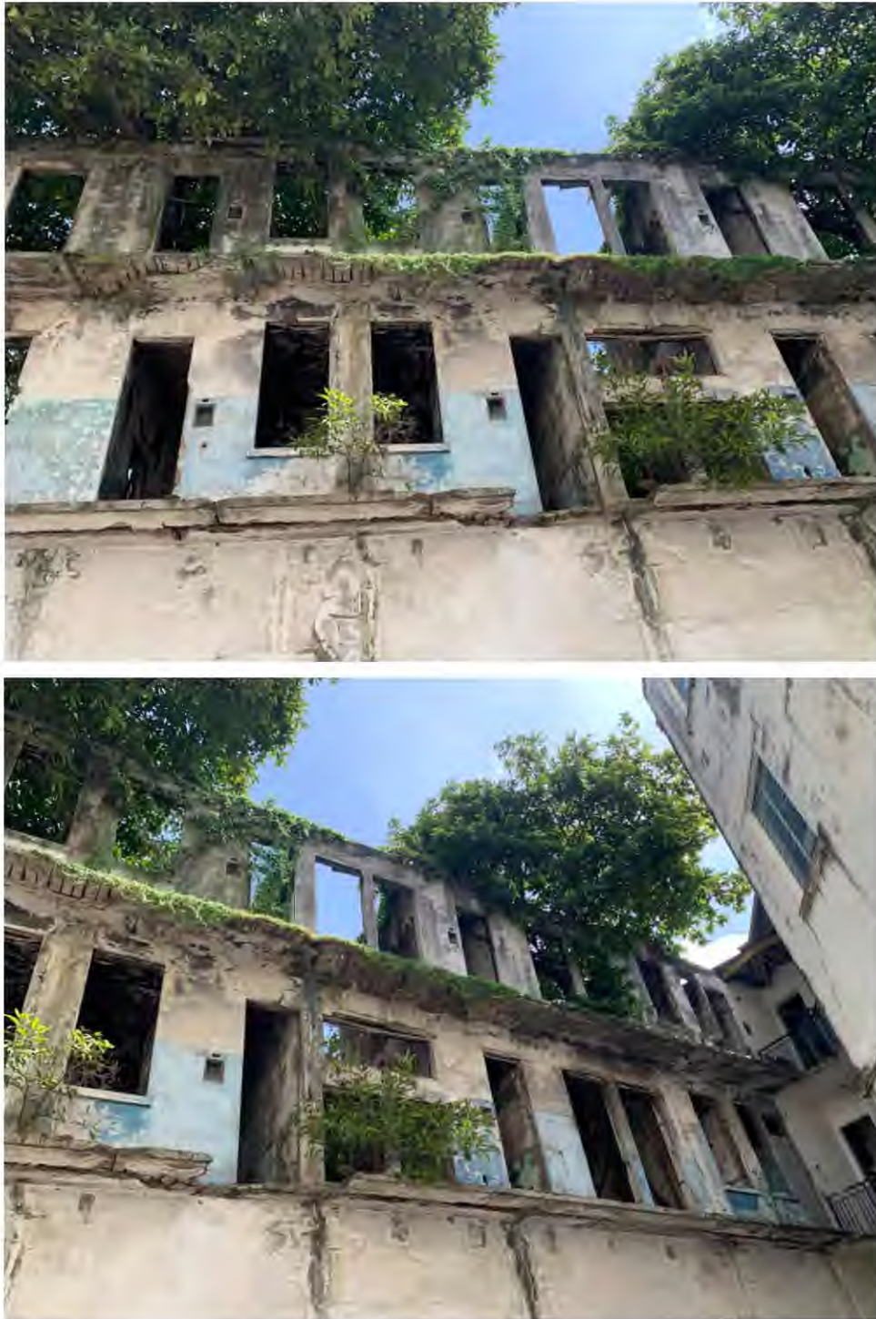
Figura 58. Compendio de fotografías: Estado actual fachada interior B
