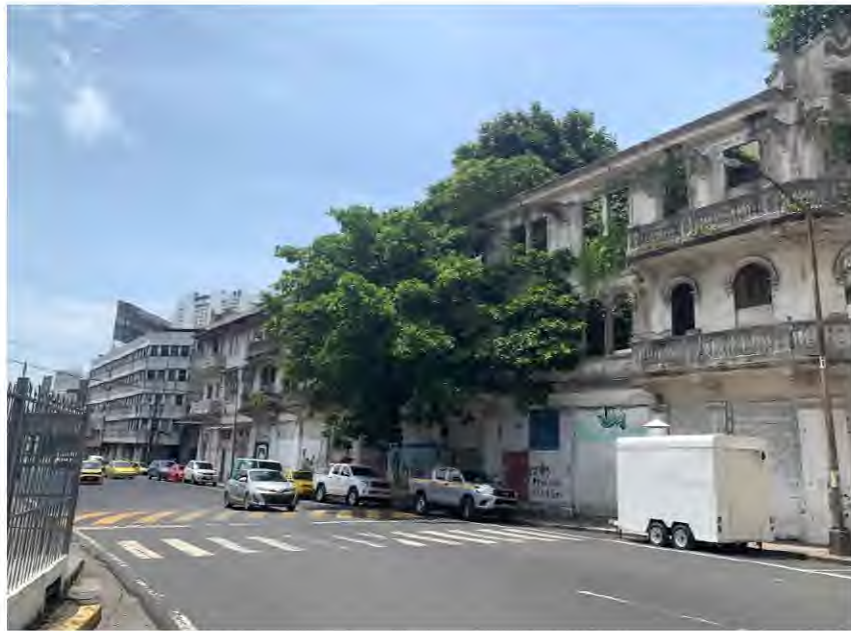
Figura 48. Fachada norte inmueble Finca 3390 - Calle L
