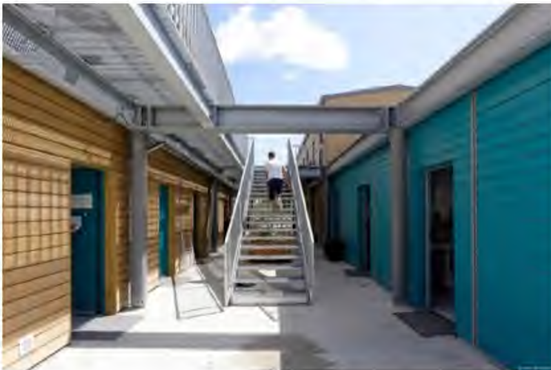
Figura 5 Vista de interior del refugio
