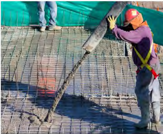
Figura 22 Cimiento de hormigón armado
