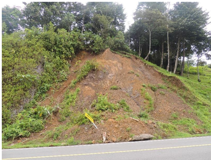
Anexo 6. Deslizamiento rotacional en la carretera de Punta Peña. Foto por: (Nicole Leong) .
