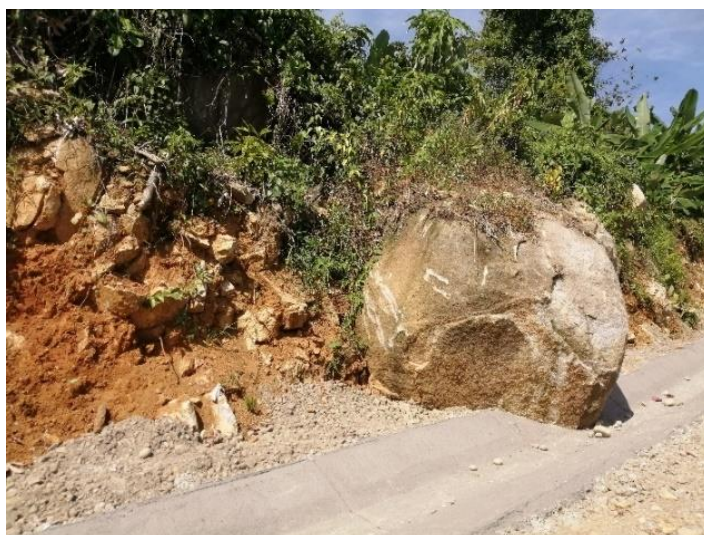
Figura 26. Bloque depositado en el sitio. Foto por: (Nicole Leong) .
