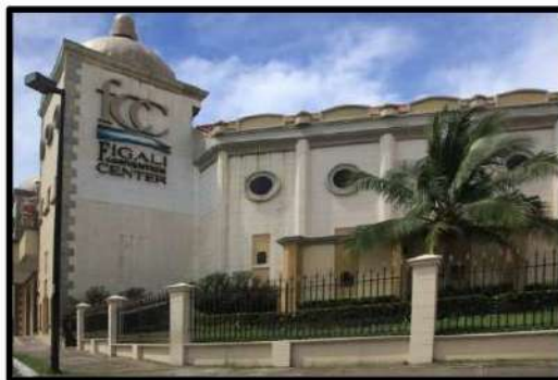
IMAGEN N° 33. Instalaciones del Centro de Convenciones Figali
