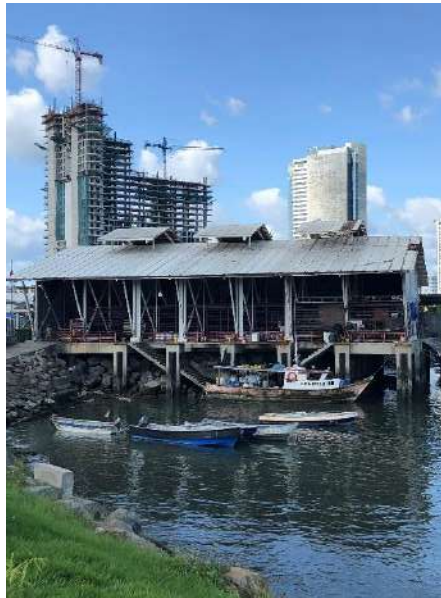
Vista lateral del edificio.
