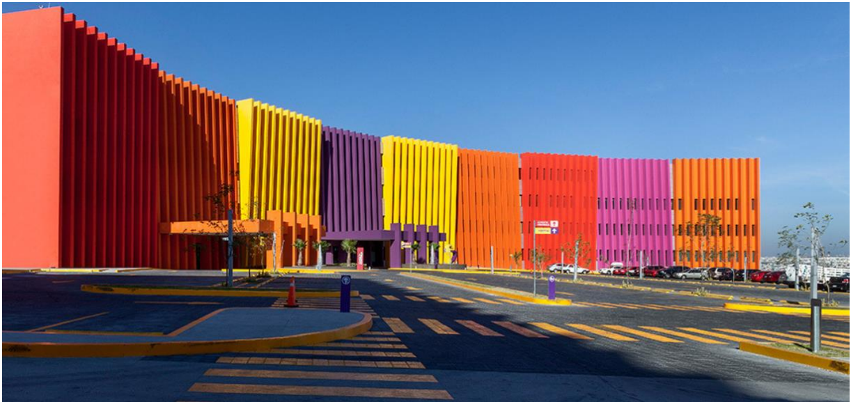
Figura 12. Centro de Rehabilitación Infantil (CRIT), entrada principal. Fuente: Jaime Navarro, 2017
