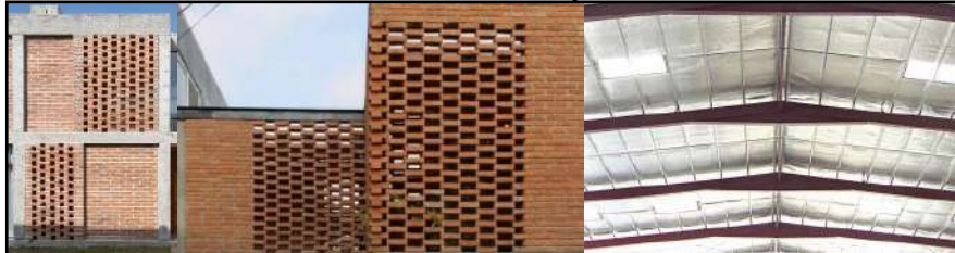
IMAGEN N° 41. Muro celosías de ladrillos y aislante térmico reflectivo
