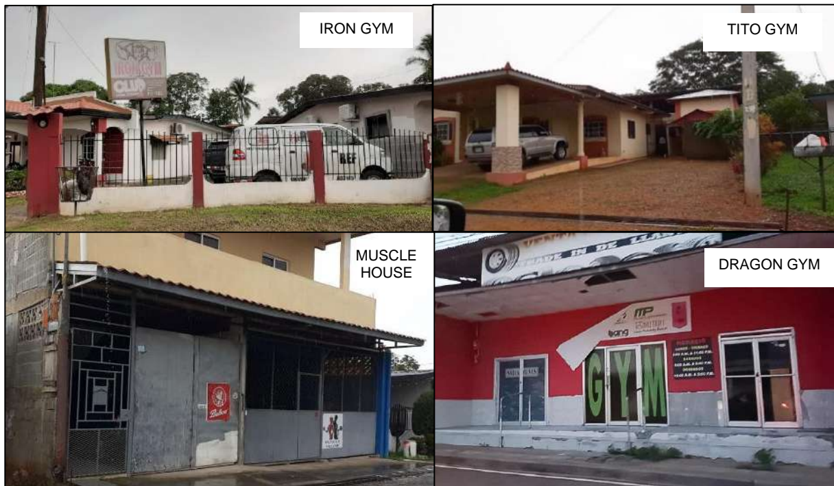
IMAGEN N° 22. Fachadas de viviendas y pequeños locales acondicionados para gimnasios en Chitré.
