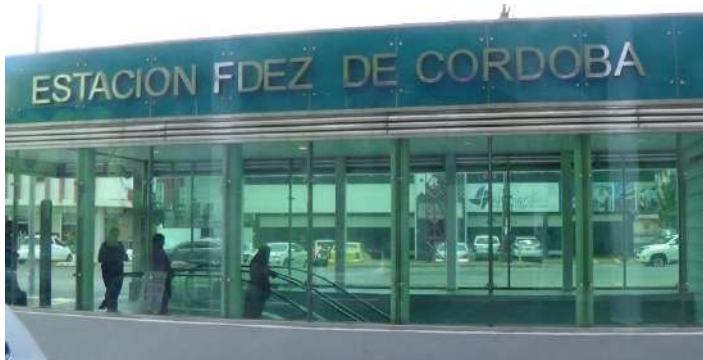
Estación de metro Fernández de Córdoba (Fig. 29) Fuente: google.com
