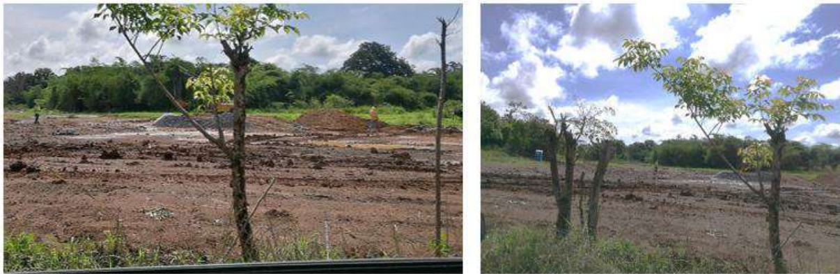
Figura 23. Trabajos en ejecución en la otra parte del terreno
