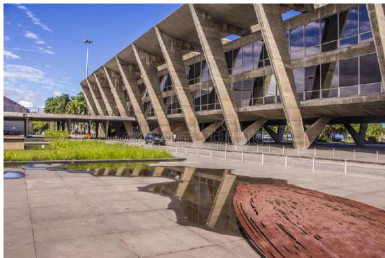
Figura 17. Vista que destaca la entrada de luz natural por los grandes ventanales del edificio
