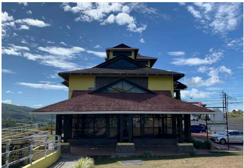
Imagen 29. Fachada lateral Centro de Exploración del café ©Autora
