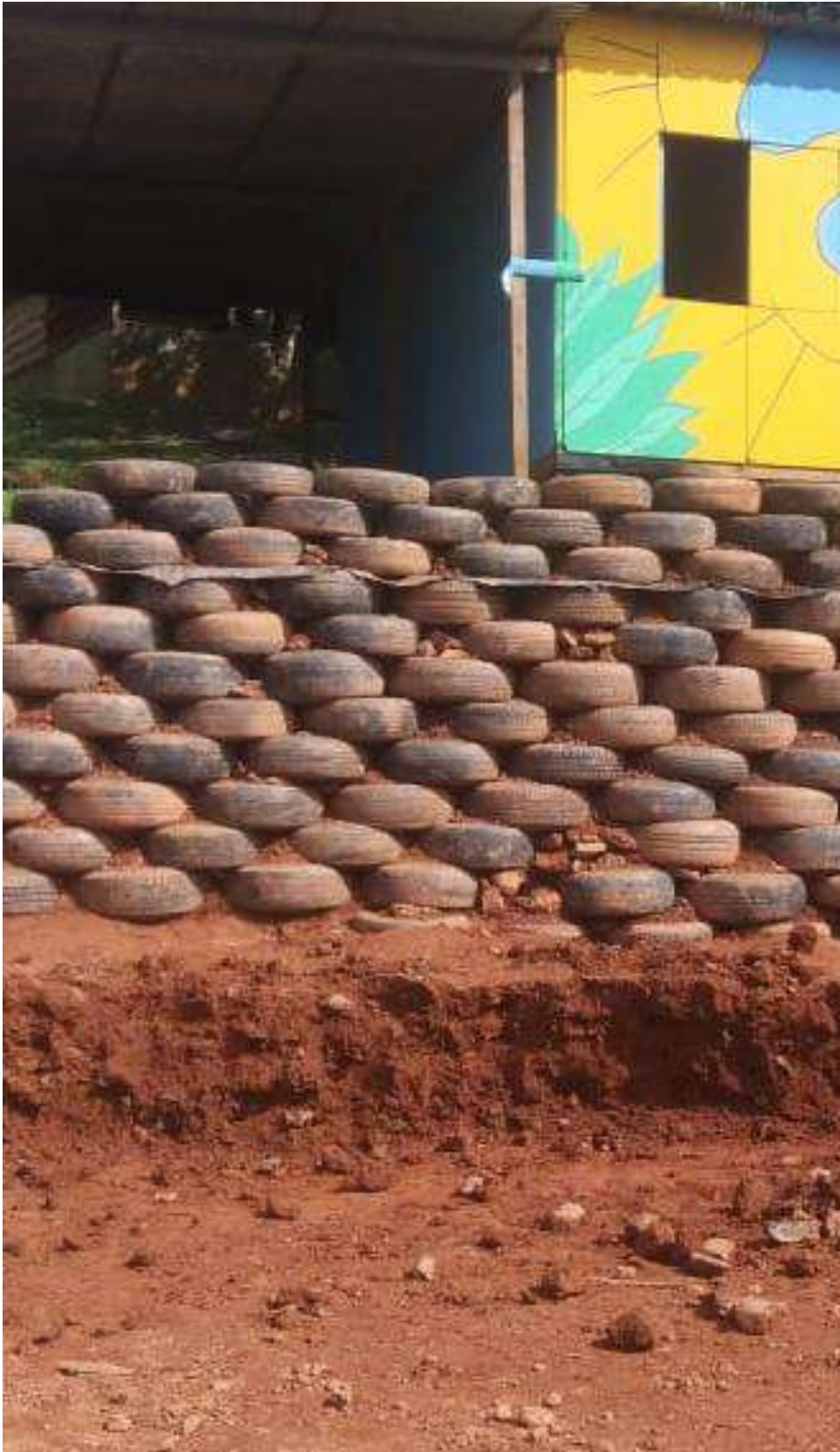
Fotografía 38. Finalización de Muro de Construcción Fuente: Fotografías del autor (2020)
