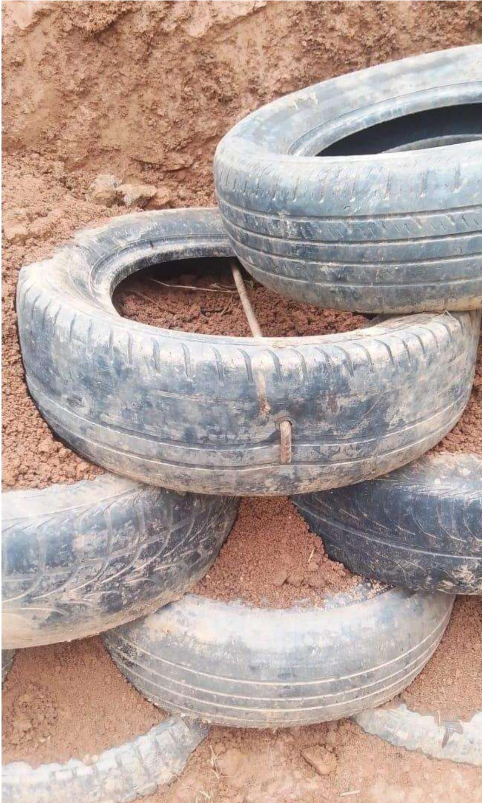
Fotografía 34. Alineamiento y amarre Fuente: Fotografías del autor (2020)
