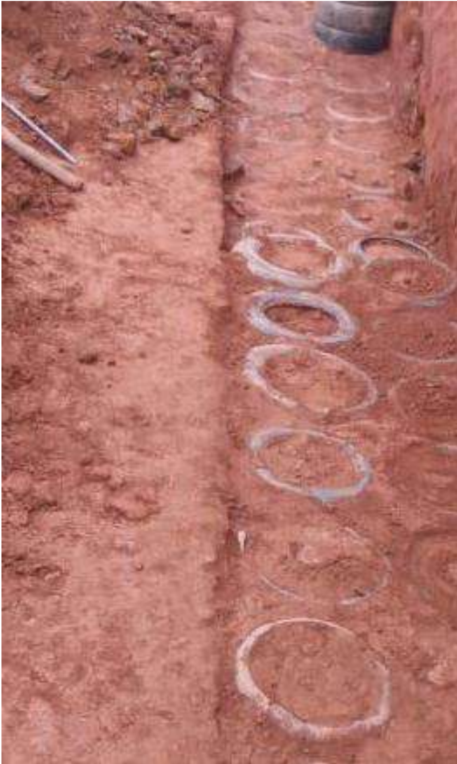
Fotografía 33. Relleno interno del Neumáticos Fuente: Fotografías del autor (2020)
