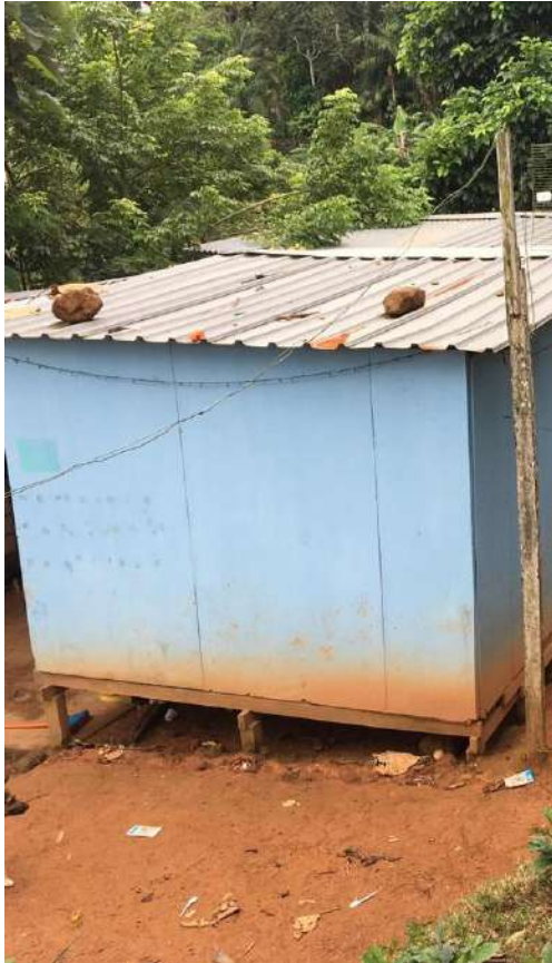
Fotografía 18. Sistema de canalización actual
