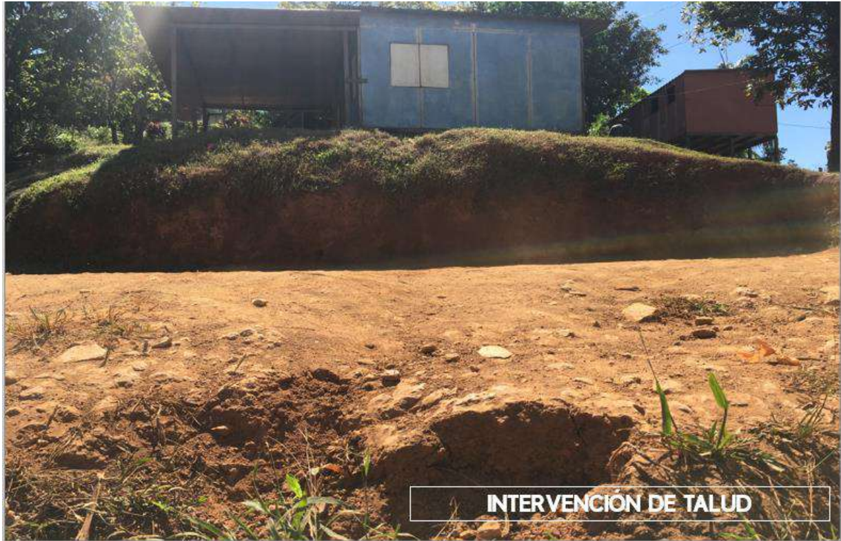
Fotografía 21. Intervención de talud
