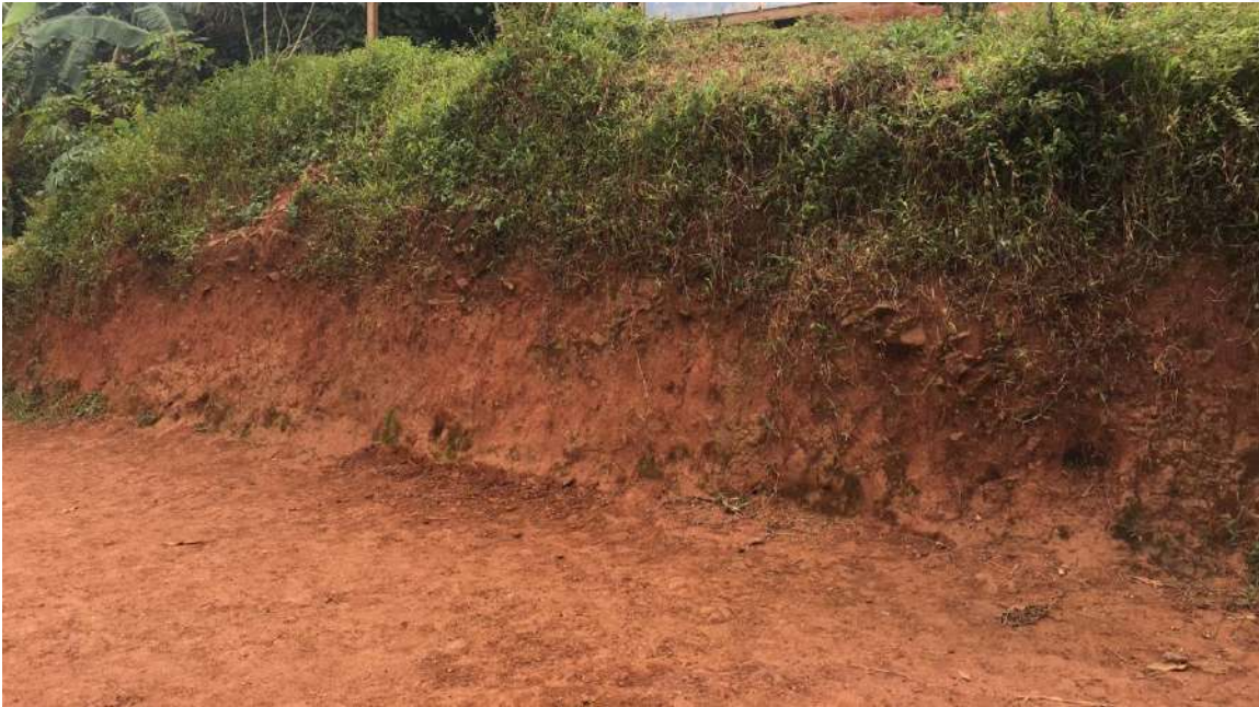
Fotografía 19. Análisis de Talud / antes del corte
