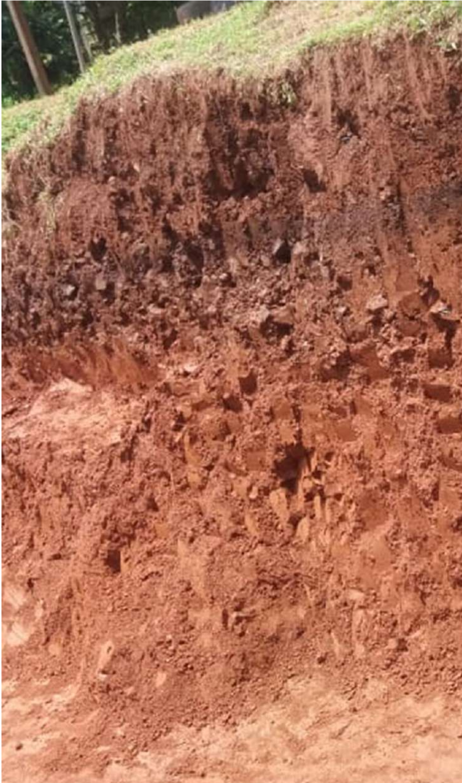
Fotografía 31. Corte de talud en la comunidad Fuente: Fotografías del autor (2020)
