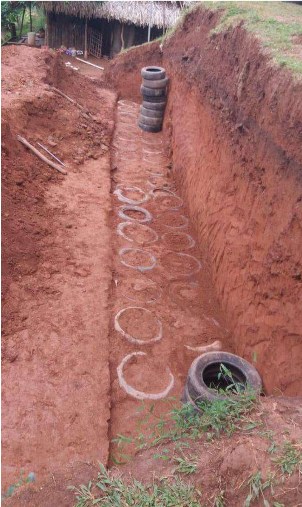
Fotografía 32. Cimentación de Talud de Neumáticos
