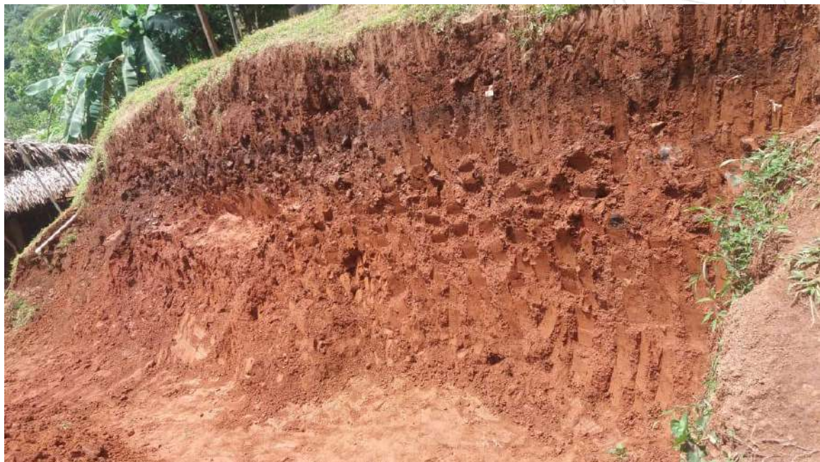
Fotografía 20. Análisis de Talud / después del corte
