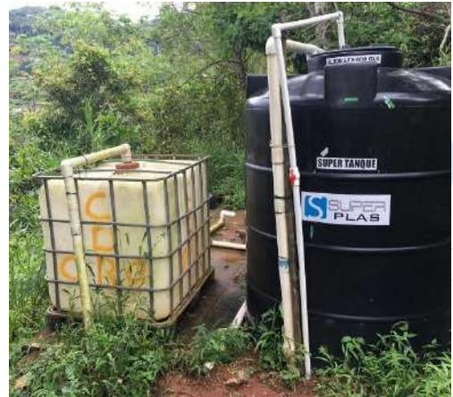
Fotografía 7. Tanque de Agua
