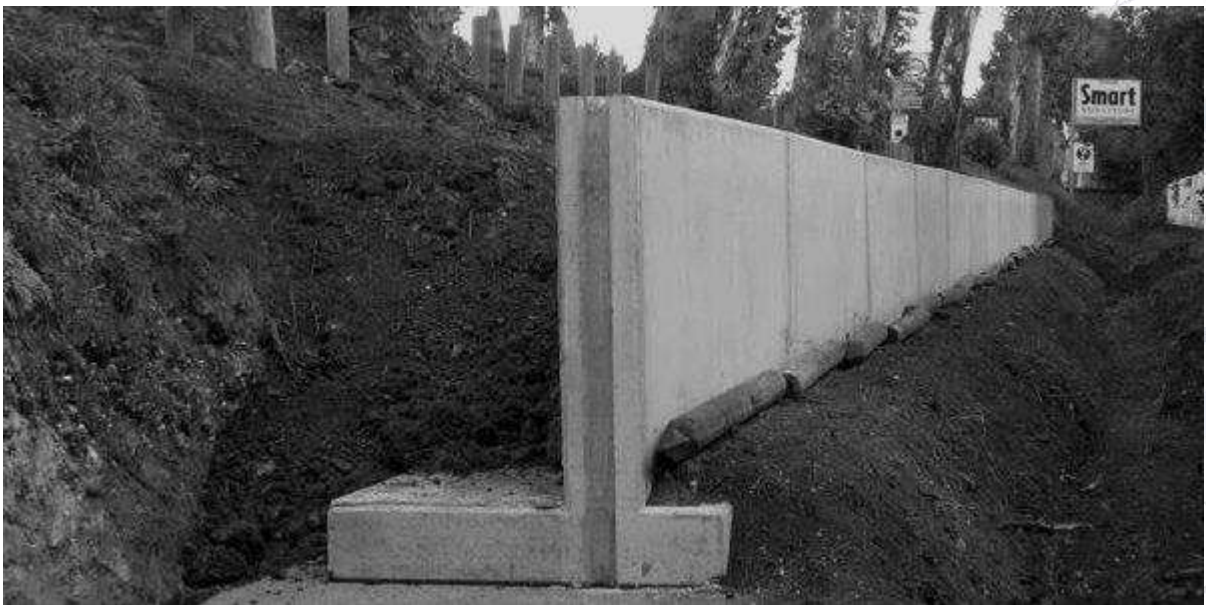
Fig 21. Estructura de Muro de Contención
