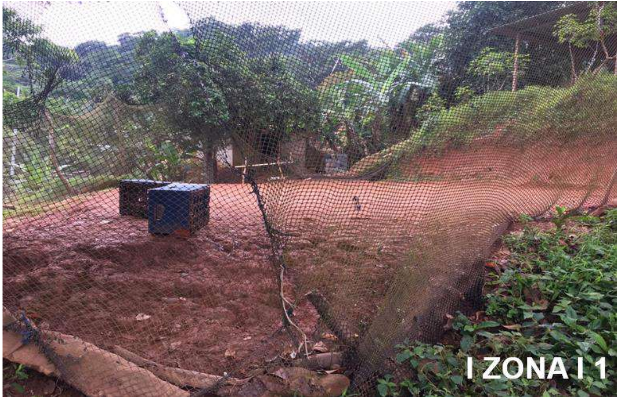
Fotografía 11. Zona de intervención de zona 1 / cancha deportiva
