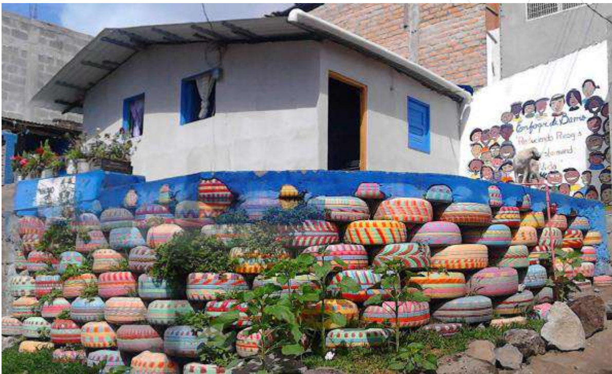
Fig 28. Muro de Neumáticos en casa Modelo
