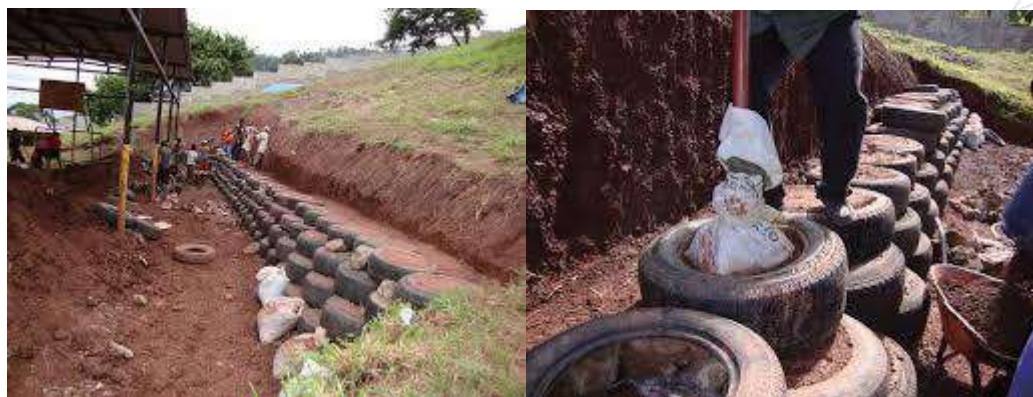
Fig 29. Muro de Neumáticos Esc. Primaria Emmanuel
