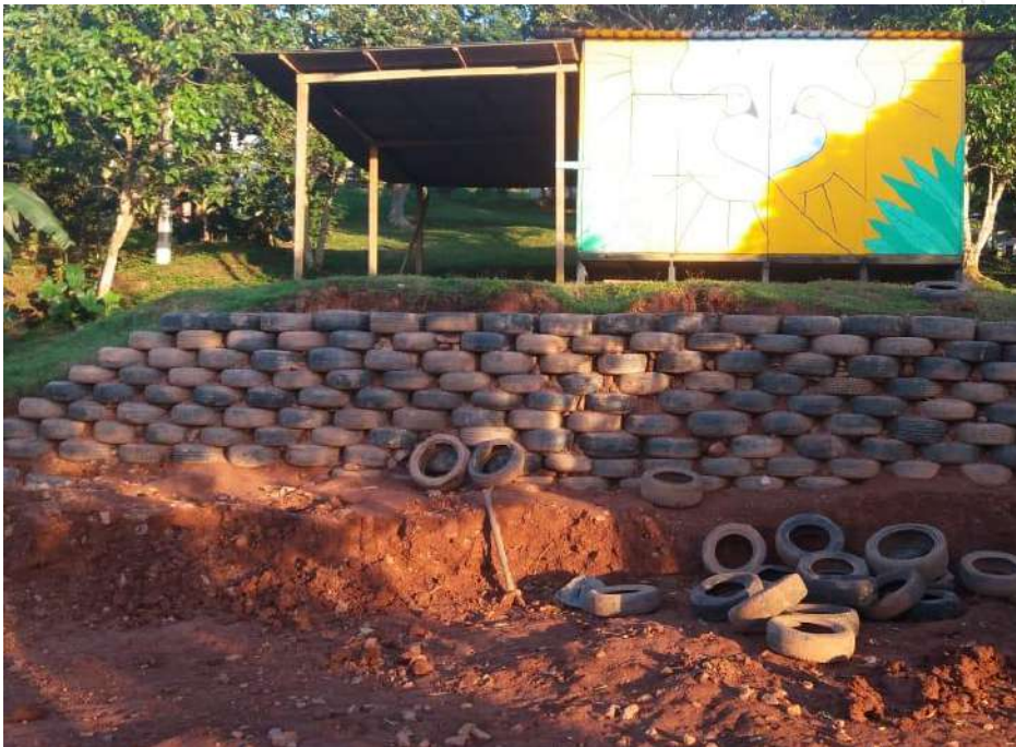
Fotografía 37. Muro de Neumáticos Finalizado Fuente: Fotografías del autor (2020)
