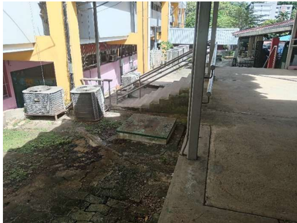
FIGURA 18. Vistas de escaleras hacia talleres
