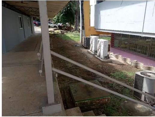
FIGURA 16. Vista de desnivel hacia los talleres
