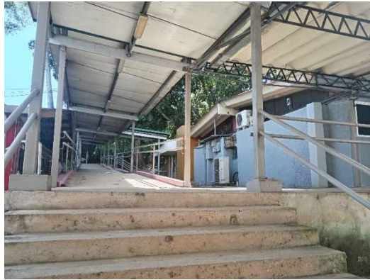
FIGURA 17. Vista rampa hacia los talleres
