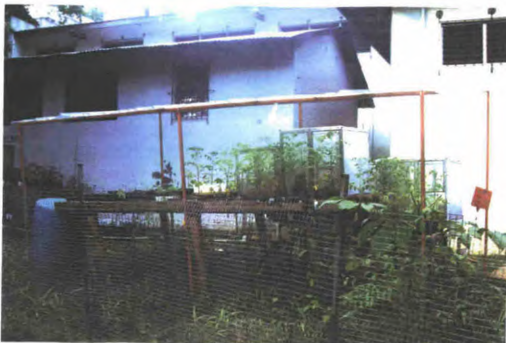
Fig. 1: Estructura metálica con techo de lámina transparente, diseñada para la protección de las jaulas con plantas sanas y cría en área aledaña al Insectario.
