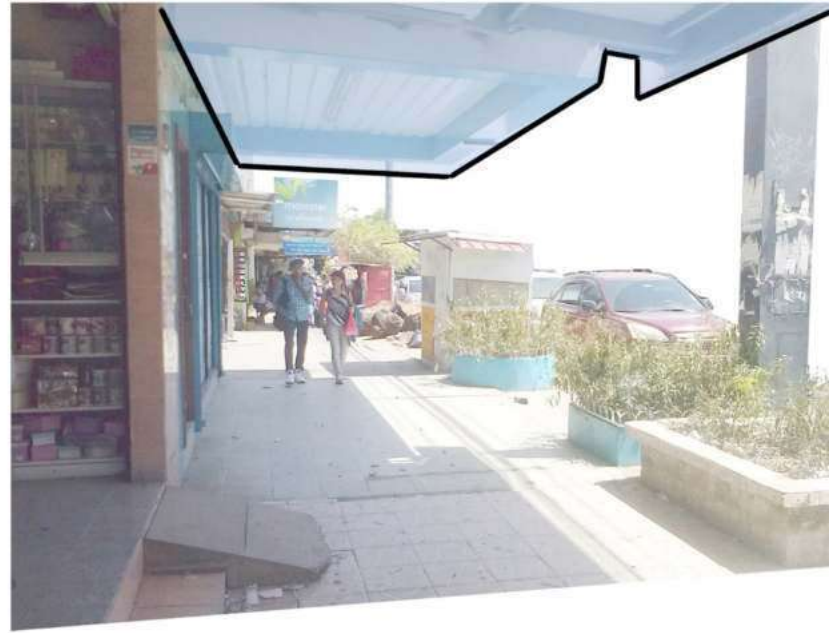
Figura 44. Fotografía de Cubiertas en acera, Ave. Juan D. Arosemena.
