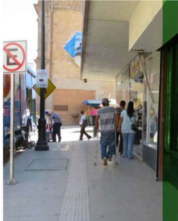
Figura 68. Pavimento Podotáctil, Saltillo, México Nota. Pavimento de avance en el centro de una acera para evitar obstáculos. Adaptado de Guía de diseño de infraestructura peatonal . Instituto Municipal de Planeación, 2014-2017.
