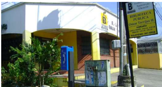
Imagen_12. Fachada de la Biblioteca Omar Torrijos Herrera.
