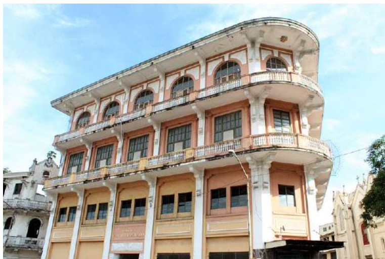
Imagen_11. Fachada de la Biblioteca Eusebio A. Morales.
