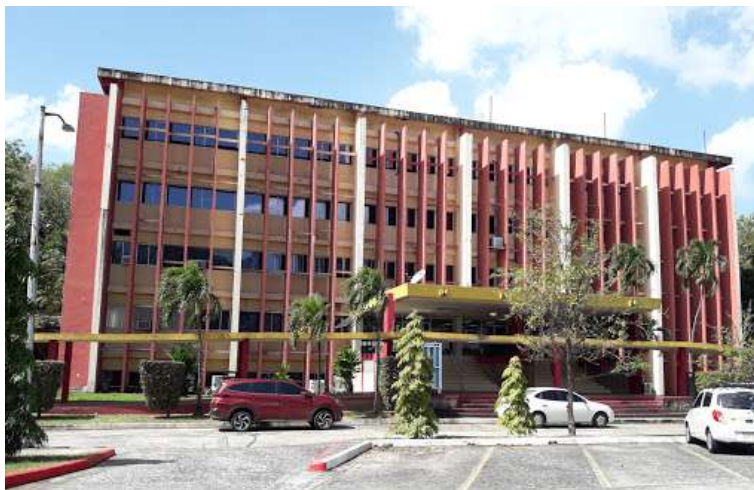
Imagen_01. Vista frontal de la Biblioteca Simón Bolívar.
