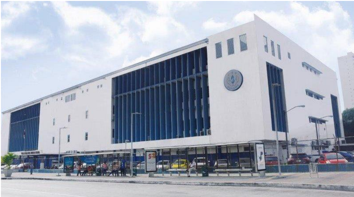
Imagen N°27. Fachada principal de la policlínica de Calidonia Fuente: Prensa CSS
