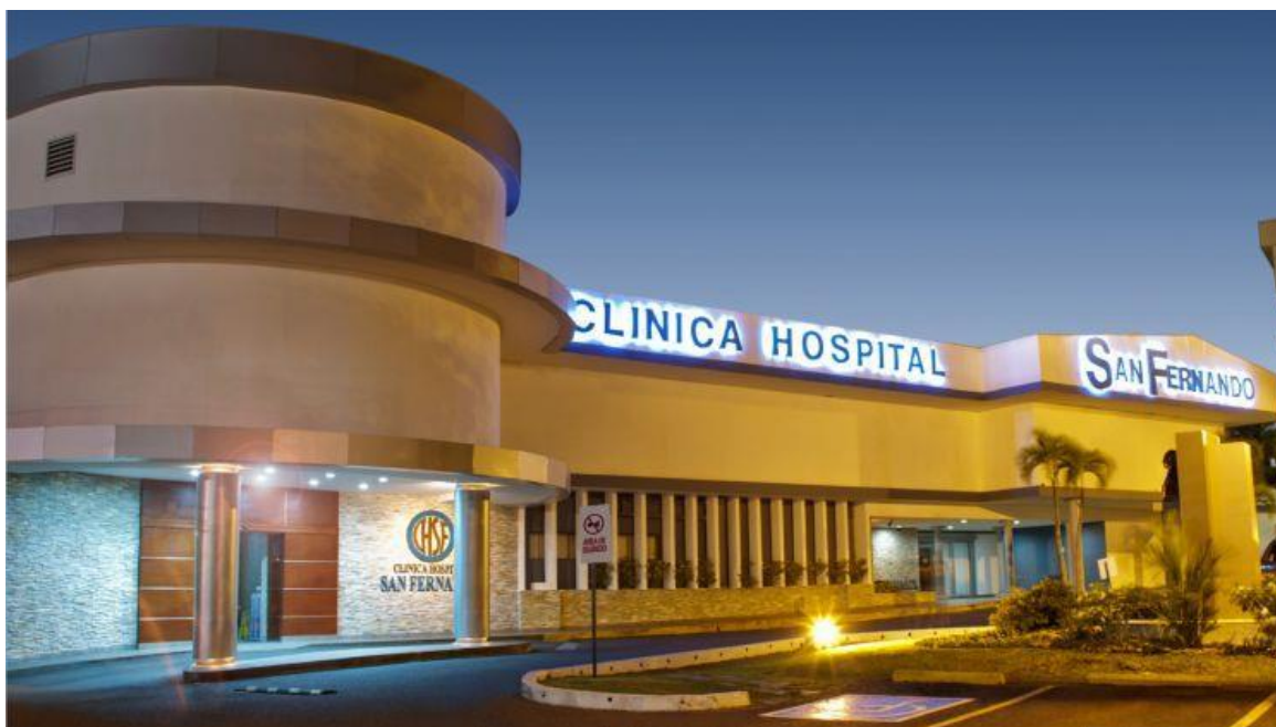
Imagen N°26. Fachada principal de la Clínica Hospital San Fernando Fuente: www.hospitalsanfernando.com
