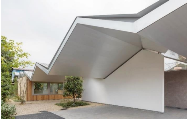
Imagen N°32. Vista de la entrada principal Takashige. Fuente: www.Plataformaarquitectura.com
