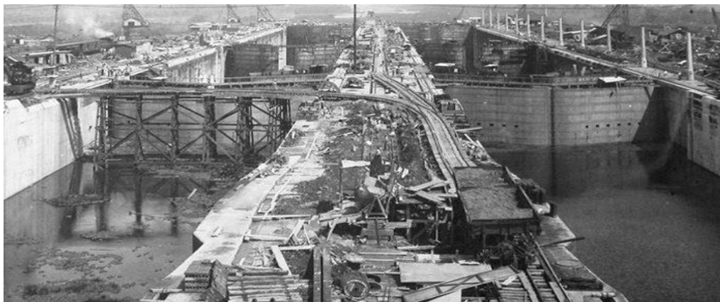
Imagen N°20. Imagen de la construcción del Canal.
