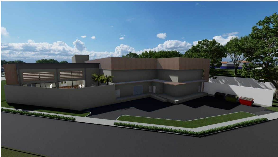
Imagen N°75. Vista de fachada posterior. Fuente: Creado por el autor.
