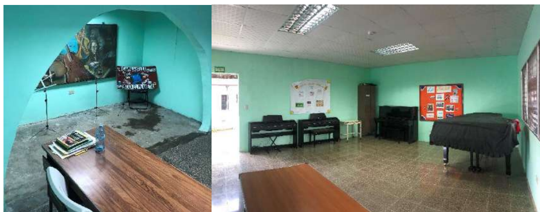
Imagen 30. Estado actual de aulas de música del CESBAF. Dayara Caballero, 2023.
