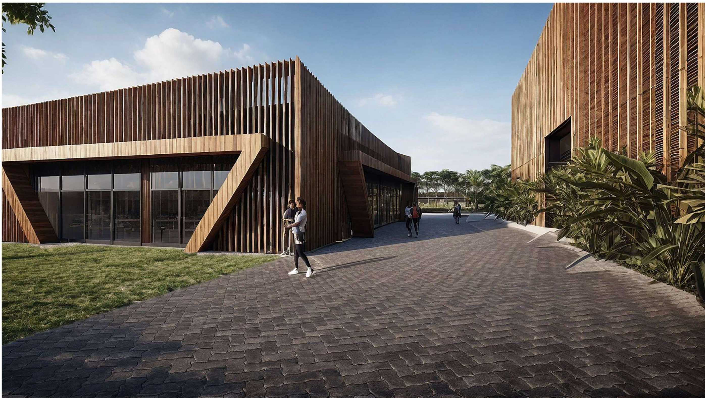
Vista: Exterior Cafetería
