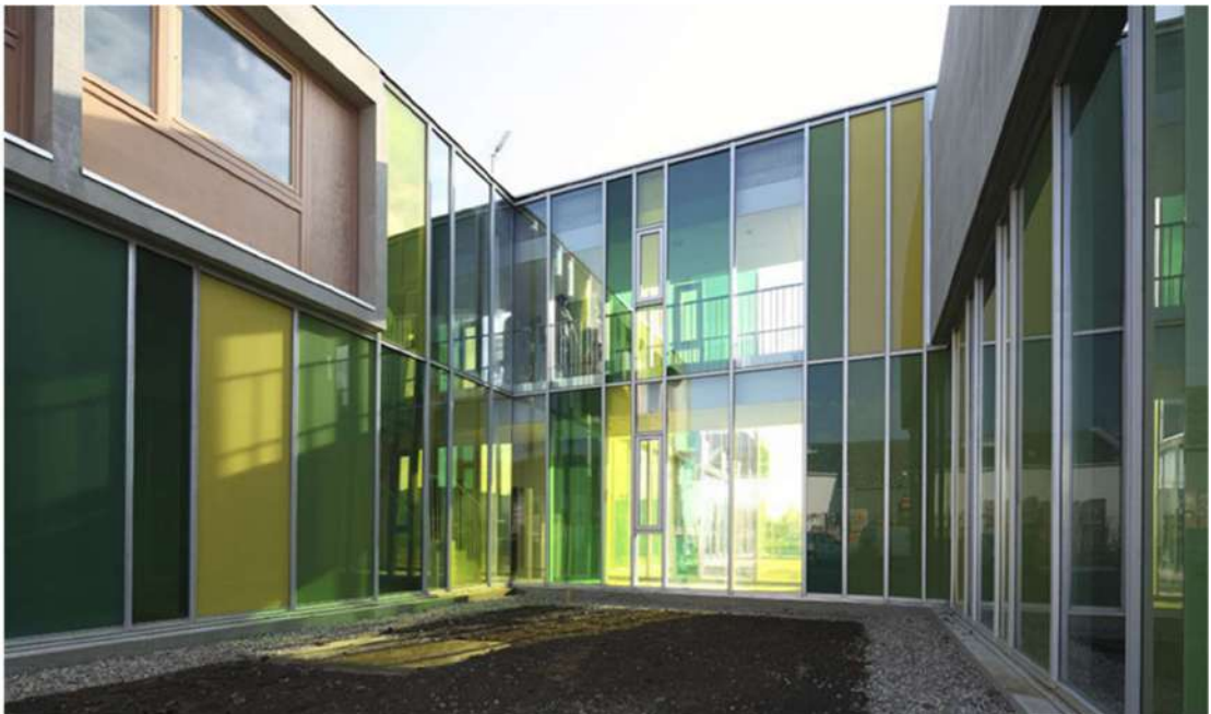
Imagen 6: Vista exterior - Centro de Recepción y Reintegración Social, Residencia Henri Durand, Francia
