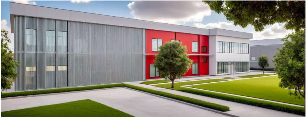
Imagen 73: Vista frontal de Edificio No.1
