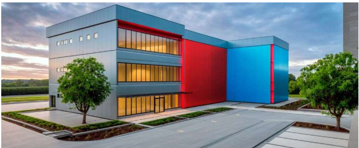
Imagen 75: Vista frontal de Edificio
