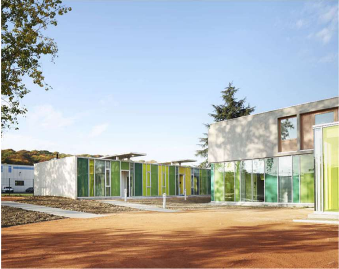
Imagen 7: Vista exterior 2 - Centro de Recepción y Reintegración Social, Residencia Henri Durand, Francia
