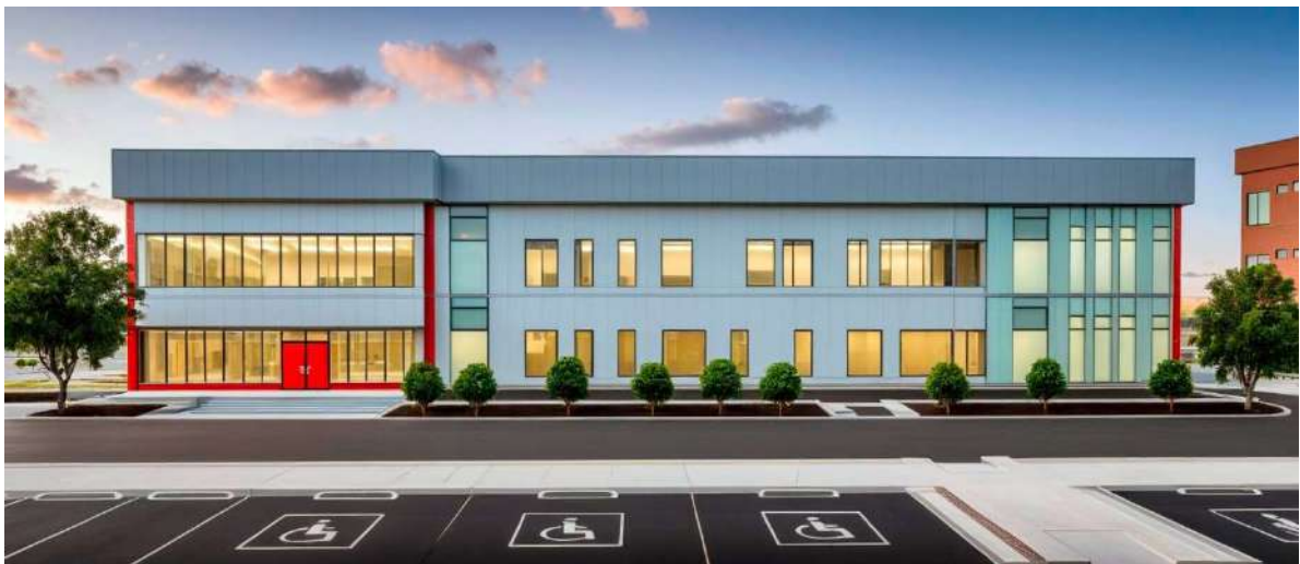
Imagen 74: Vista frontal de Edificio No.2
