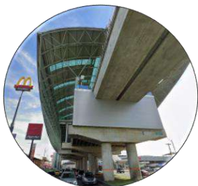
Estación Metro Villa Lucre
