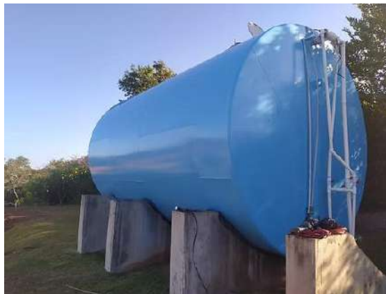
[Figura 37. Tanque de Reserva de Agua. Fuente: Limpieza de Tanques de Agua en Panamá. (s. f.)]
