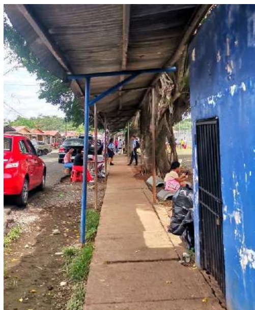
Ilustración 22. Acera del C.E.B.G. Residencial Vista Alegre. © Yesibeth Ruíz, 2024
