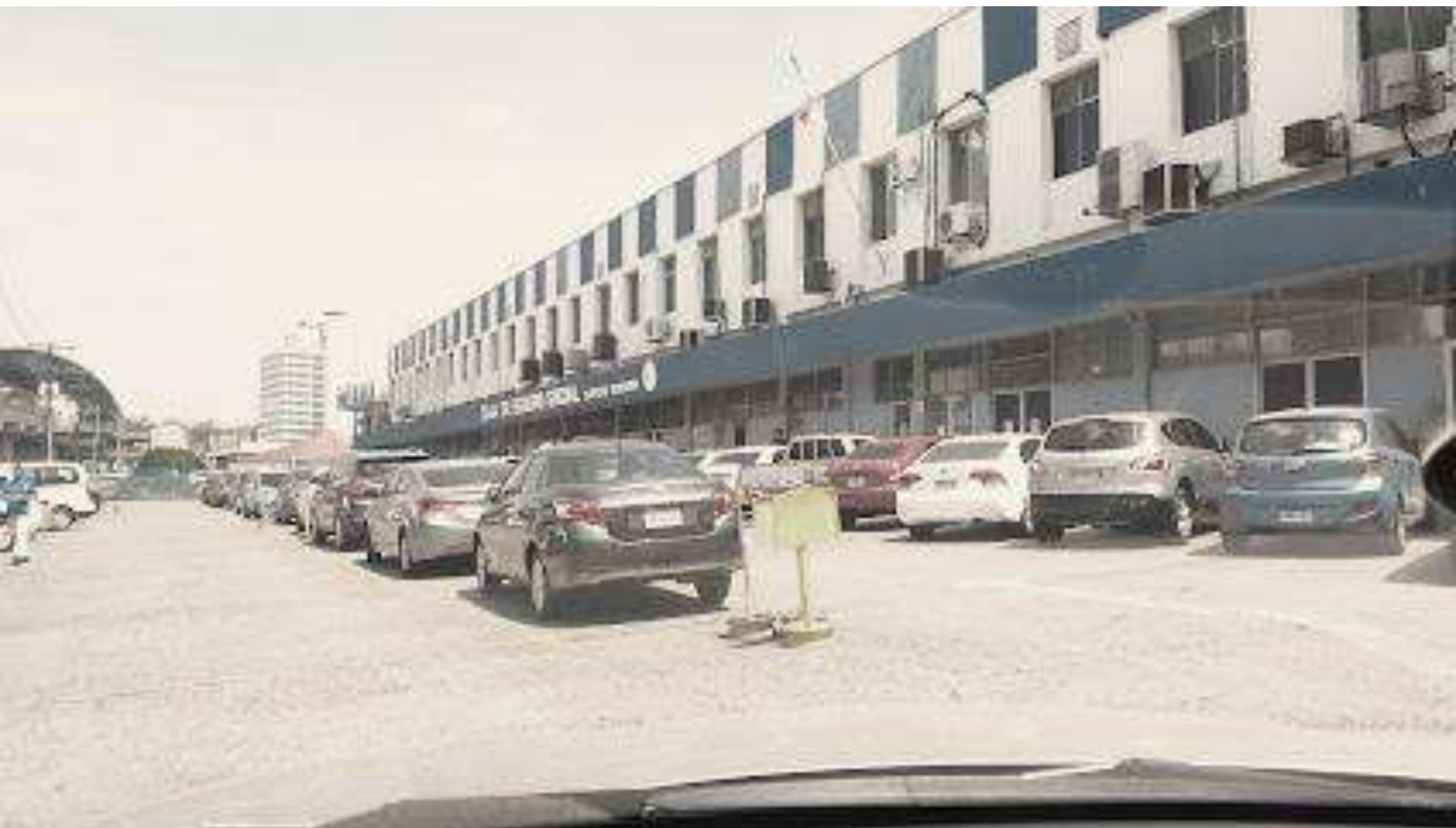
Ilustración 19: Foto de la CSS del Edificio Bolívar. (Foto: A. Guillén)
