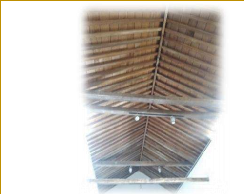
Ilustración 101. Estructura (alfarje) de par e hilera (Foto propia).
