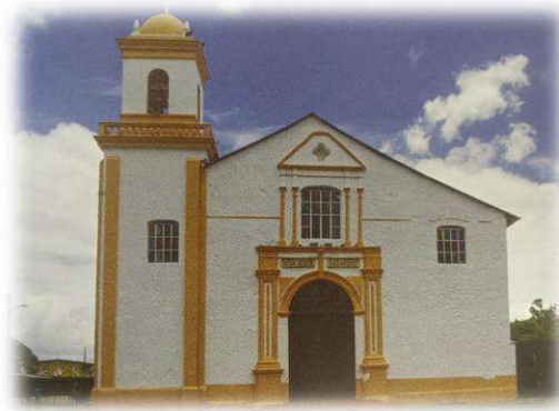
Ilustración 119. Fachada principal de la iglesia. Fotografía de Juan Albarrán, marzo de 2015.
