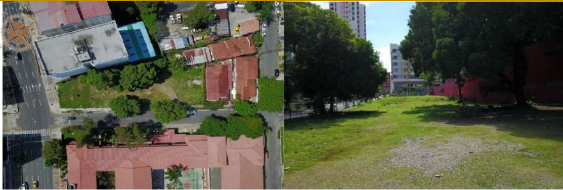
Ilustración 199, 200. Vista en planta y vista desde la parte posterior del lote.
