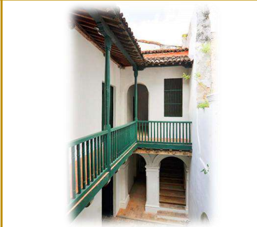
Ilustración 100. Patio de la casa. Al fondo se aprecia la escalera reconstruida (foto: E. Tejeira; 2013).
