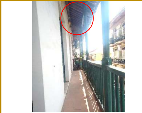
Ilustración 102. Vista interior de balcón corrido. Donde se aprecia los canecillos del alero inclinados (Foto propia).
