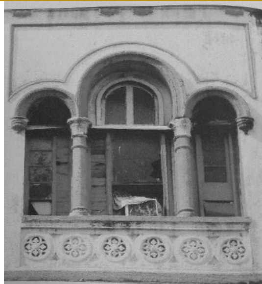
Ilustración 123. Detalle actual de la fachada, arco doblado con columnas y capiteles.
