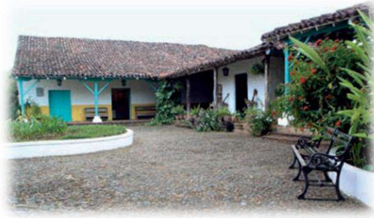
Ilustración 110. Vista posterior de la vivienda.
