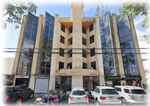
Ilustración 251. Edificio f. Floristería Farallones Panamá.
