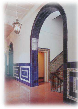
Ilustración 160. Pasillo y Escalera desde el patio Ándalus. Se observan los azulejos en las paredes y en la contrahuella de la escalera.
