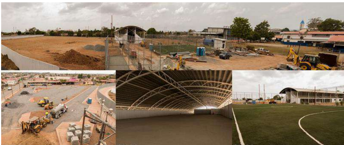
Figura N° 4 Superior: Panorámica de construcción de estadio de beisbol, y canchas de Futbol sintéticas. - Inferior Izquierda: Construcción de estacionamientos. - Inferior Centro: Área de gimnasia y cuadrilátero de boxeo - Inferior Derecha: Cancha sintética de Futbol. Fuente: Elaboración propia.
