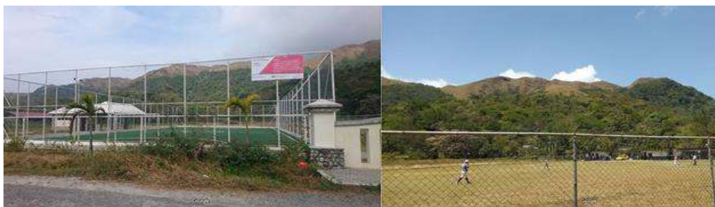
Figura N° 7 Izquierda: Exterior del Complejo Deportivo La Reforma. - Derecha: Campo de Beisbol.
