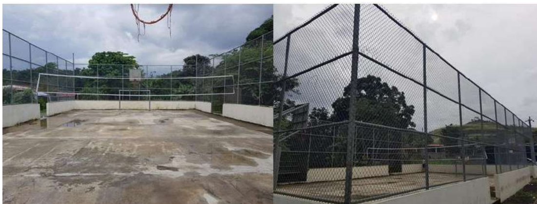
Figura N° 25 Izquierda: Interior de la Cancha Multifuncional Ciudad Bolívar. - Derecha: Exterior de la cancha. Fuente: Elaboración propia.
